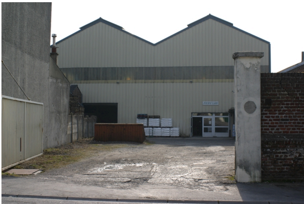
Cour et façade antérieure des entrepôts.
