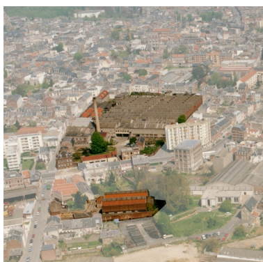
Vue aérienne de la filature Touron vers 1988-1990. Au premier plan, les entrepôts de la rue Crozat (BM Saint-Quentin).
