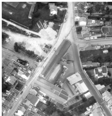
Vue aérienne, flanc sud-ouest.
