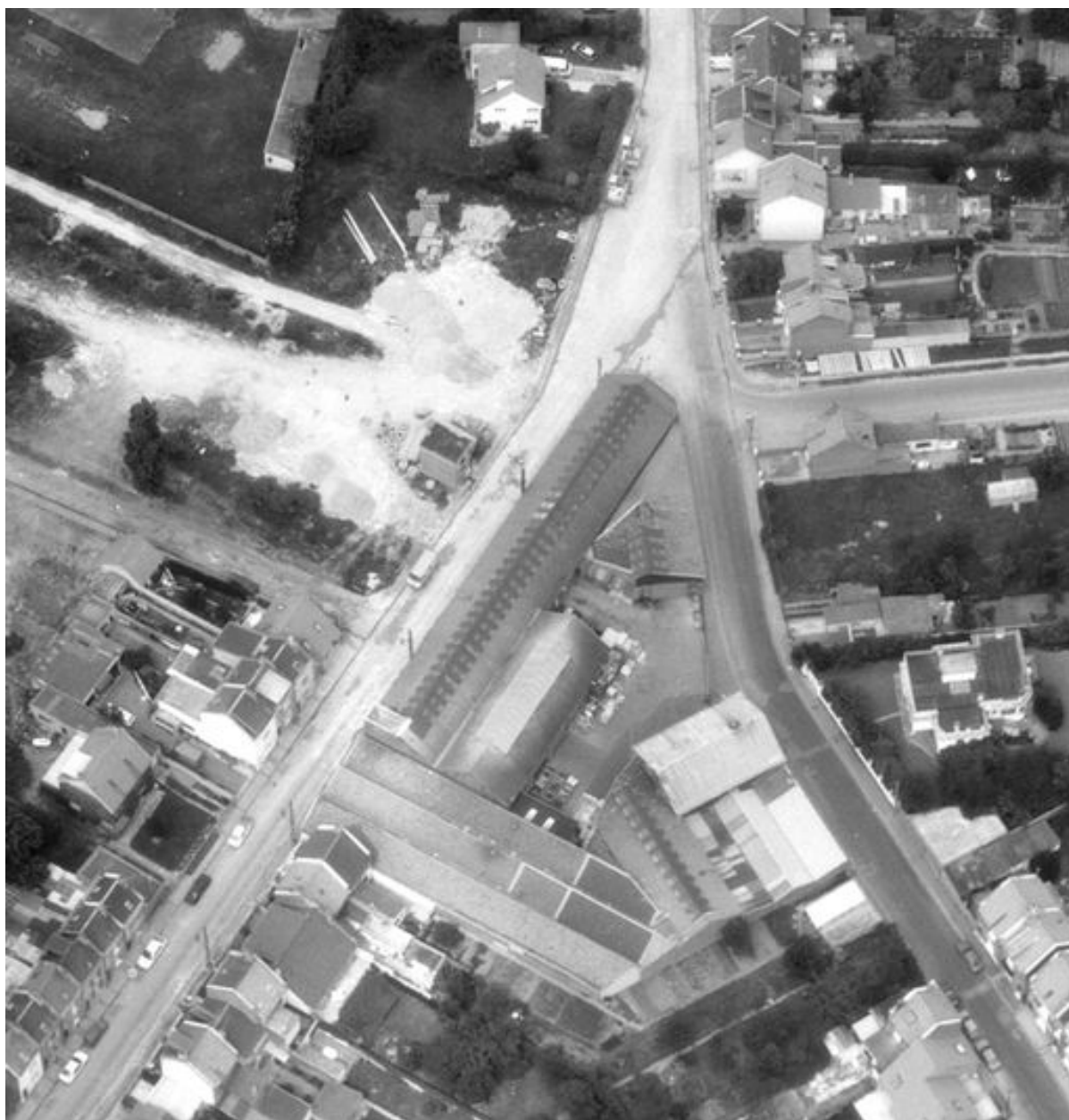
Vue aérienne, flanc sud-ouest.
