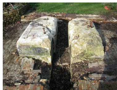
Détail du socle en pierre de la machine à vapeur.
