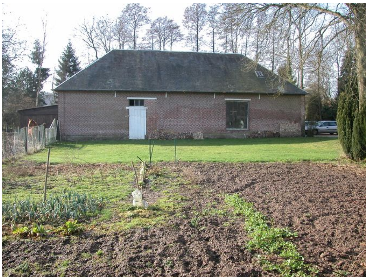
Atelier de montage, à usage actuel de remise et garage.
