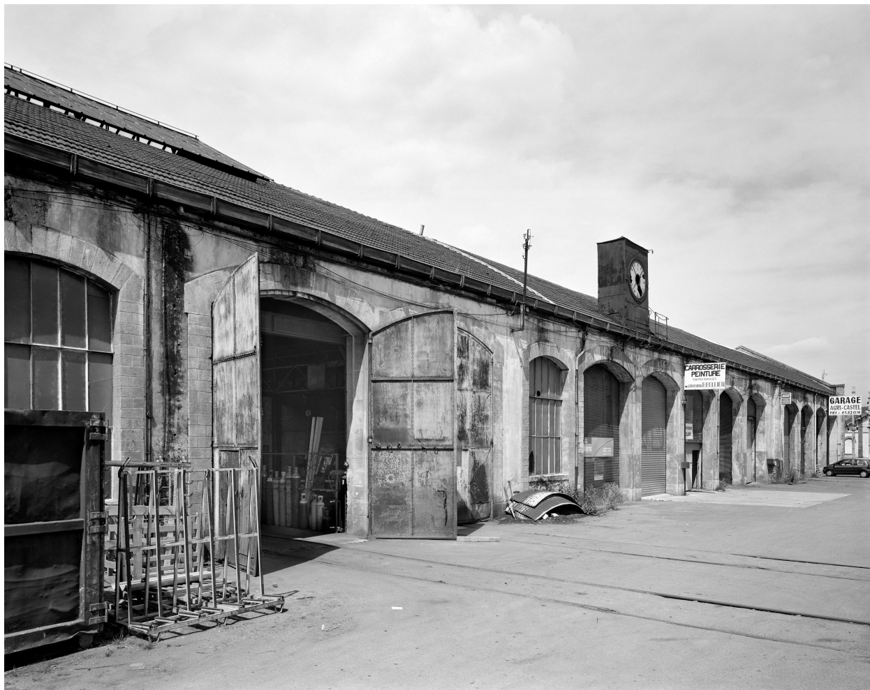
Entrepôts de réparation des locomotives : vue rapprochée.
