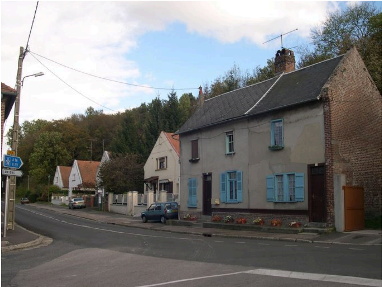
Maison, rue de Conty, milieu 19e siècle.
