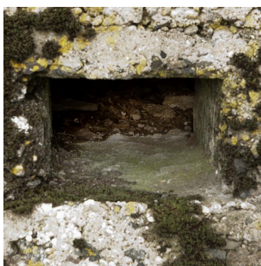
Détail de l'un des événements du dispositif de dispersion de l'onde de choc en cas d'impact d'un obus Phot. Jean-Marc Ramette IVR31_20145904624NUCA
