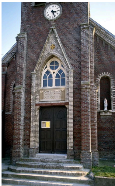
Détail de la façade occidentale.
