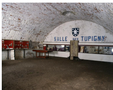
Vue générale de la salle voûtée du bastion de l'alouette, où est installé le musée du Château.
