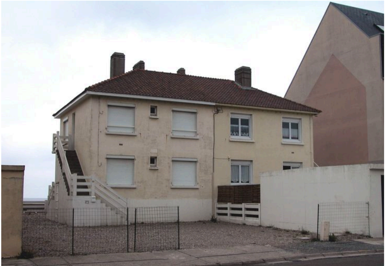
Vue d'ensemble, élévation postérieure.
