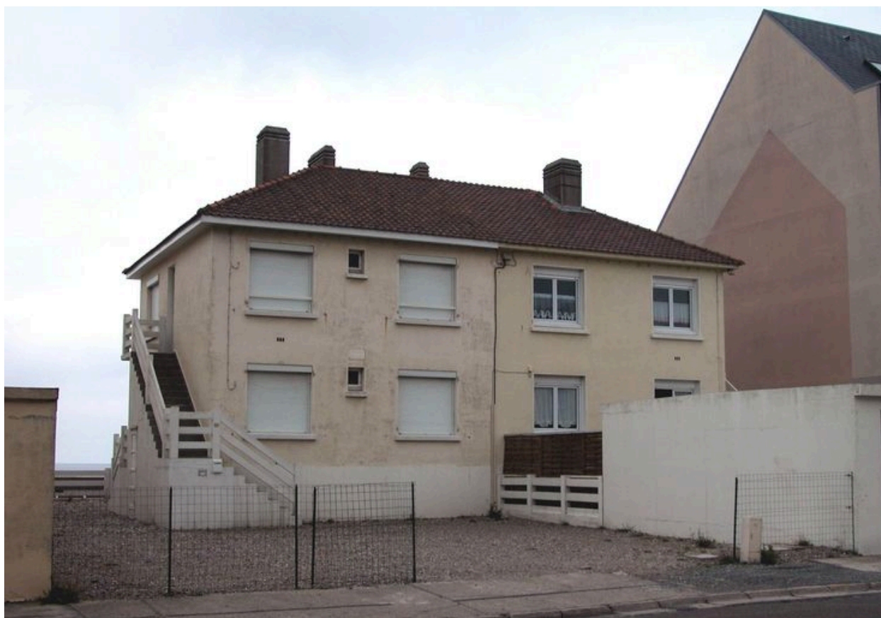
Vue d'ensemble, élévation postérieure.
