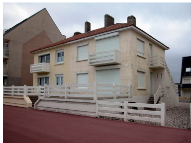
Vue d'ensemble depuis la digue. Phot. Elisabeth Justome IVR22_20058003275NUCA
