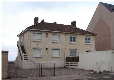
Vue d'ensemble, élévation postérieure. Phot. Elisabeth Justome IVR22_20058003276NUCA
