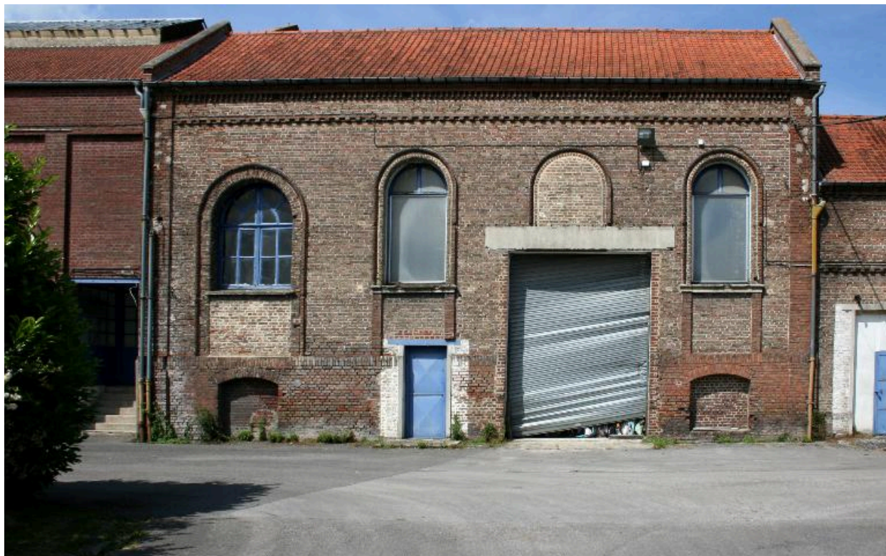
Façade sud de la salle des générateurs.
