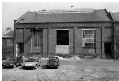
Chaufferie, état en 1988. Phot. Thierry Lefébure IVR22_19888000643X
