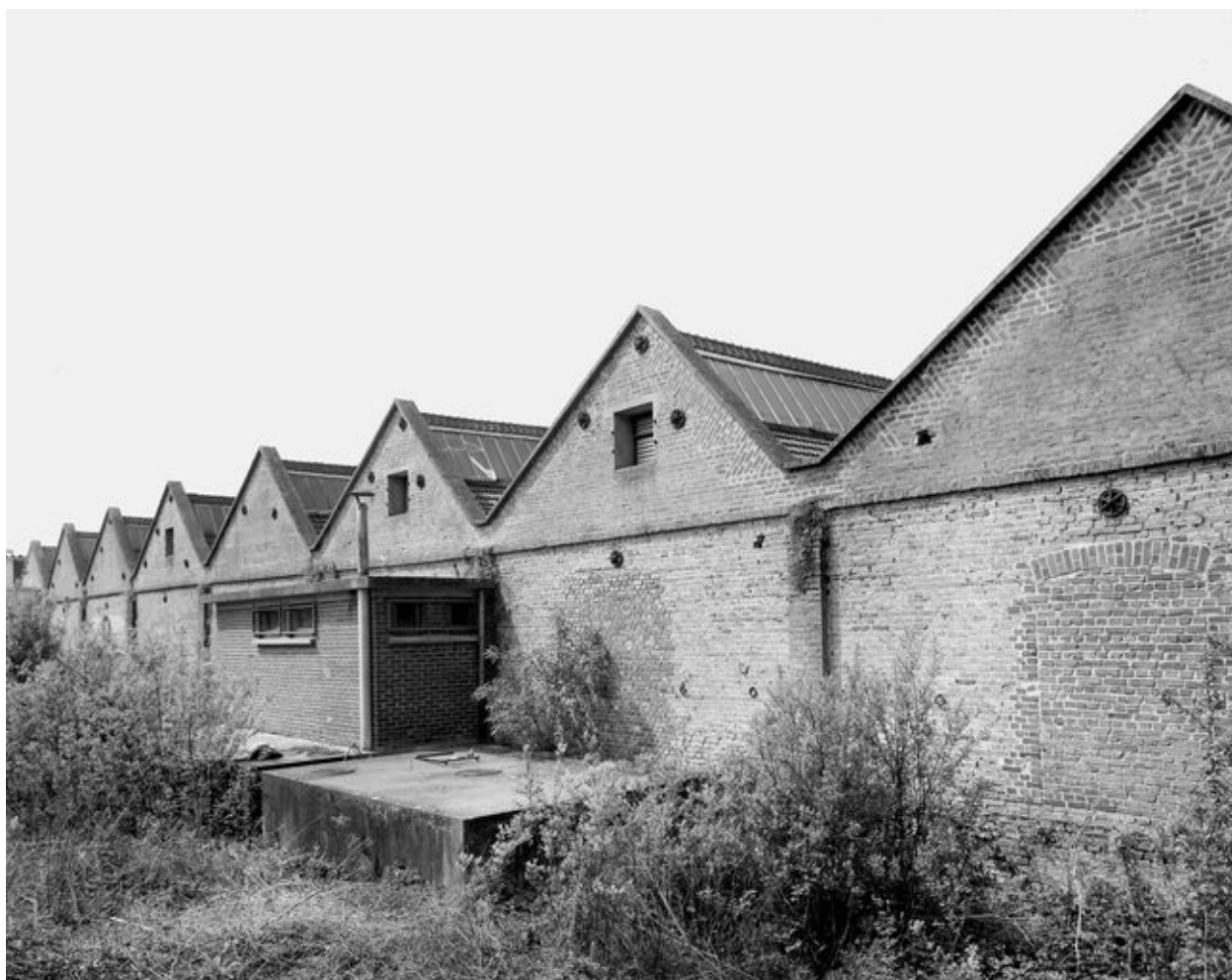
Pignon de l'atelier de tissage, état en 1988.
