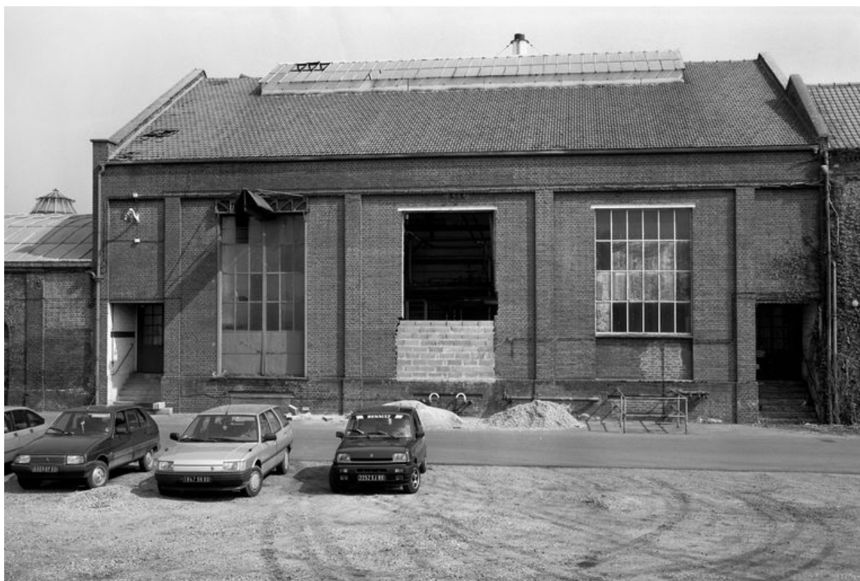
Chaufferie, état en 1988.
