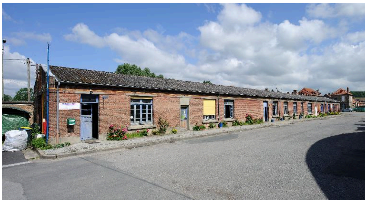
Vue d'ensemble sur cour du réfectoire.
