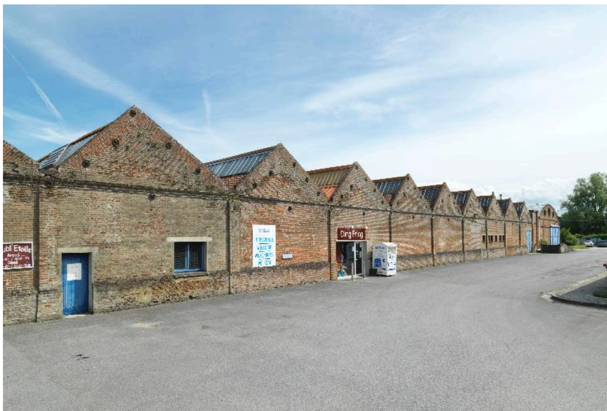
Vue d'ensemble nord-ouest de l'atelier de tissage.
