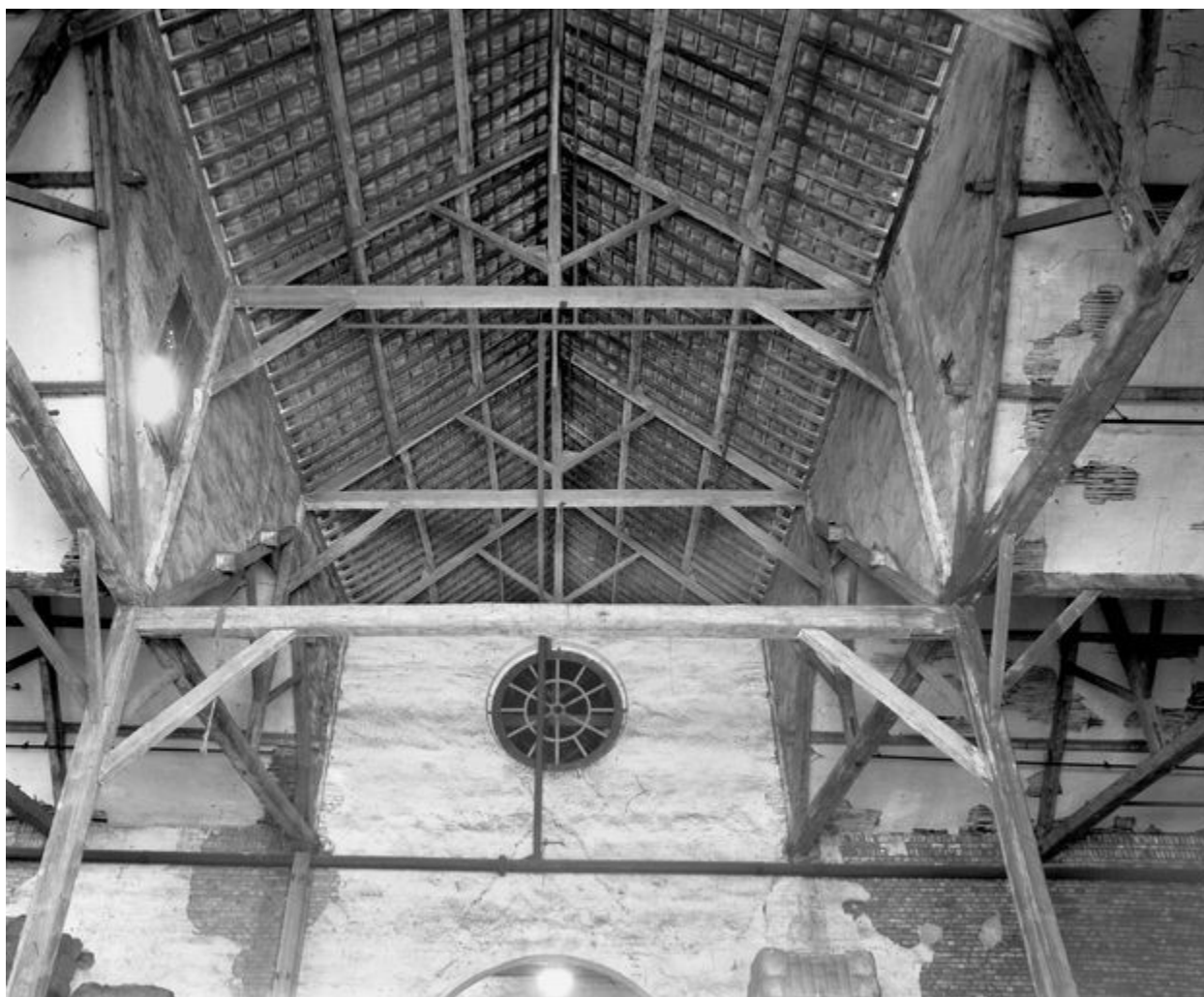
Intérieur de l'entrepôt à jute, état en 1988.
