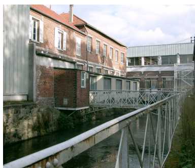
L'atelier de finition et de contrôle des produits finis. Phot. Bertrand Fournier IVR22_20046003083NUCA
