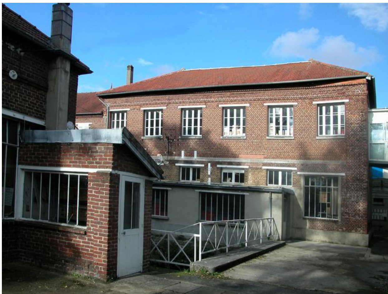
L'atelier de finition (à l'étage) et le bureau de contrôle des produits finis.
