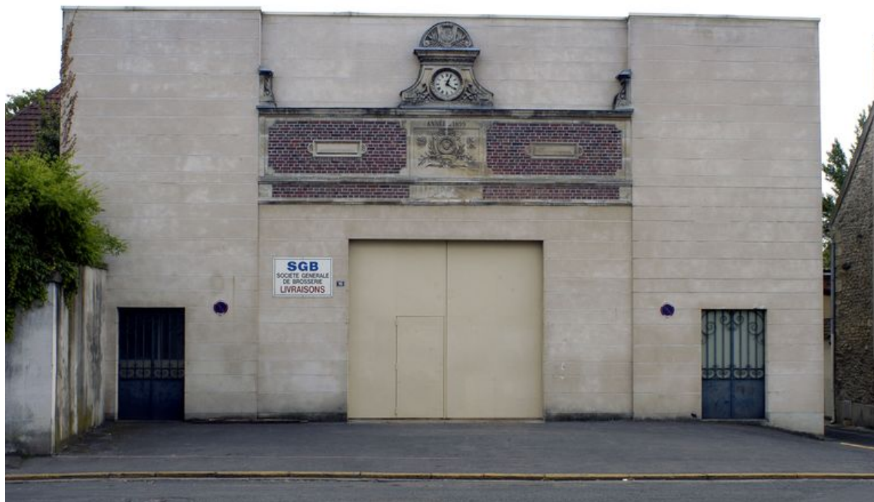
Façade sur rue du magasin industriel.
