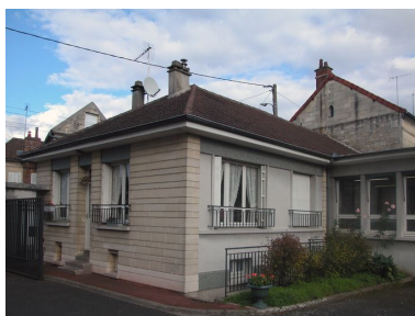
Le logement du concierge. Phot. Bertrand Fournier IVR22_20046003042NUCA
