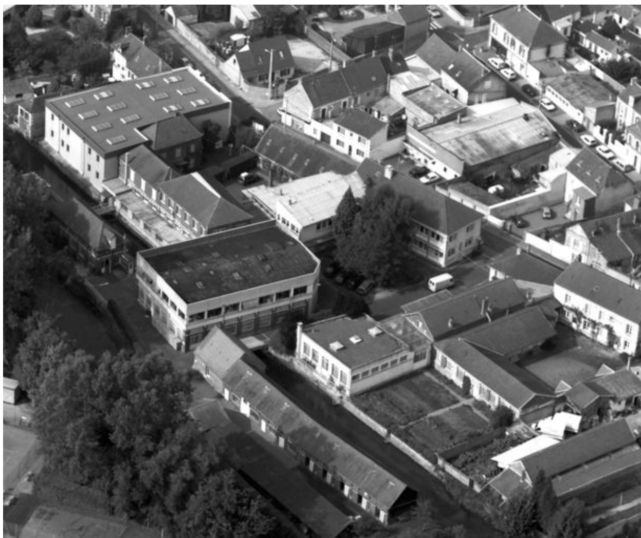
Vue aérienne de l'usine de broserie en 1993.
