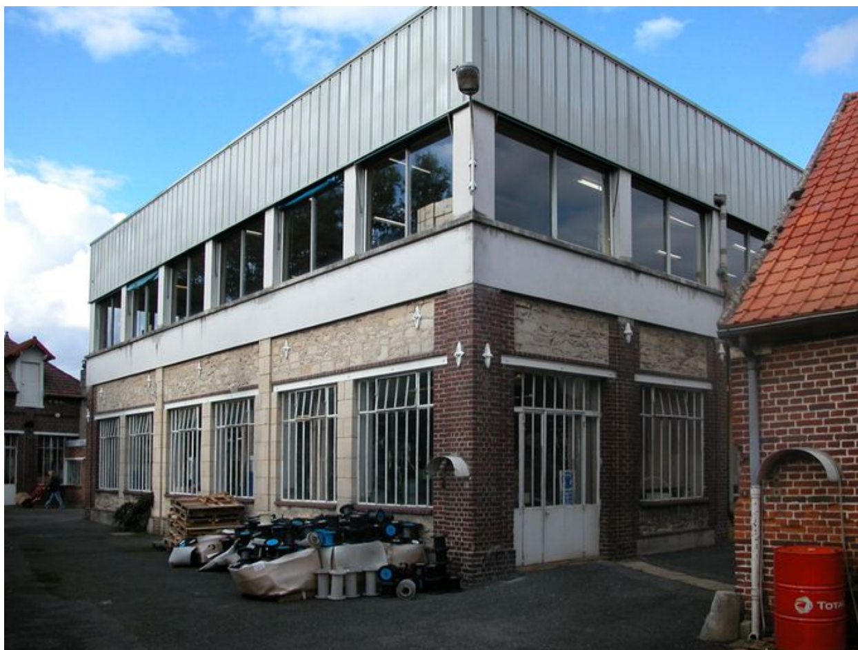
Façade postérieure de l'atelier de fabrication principal.
