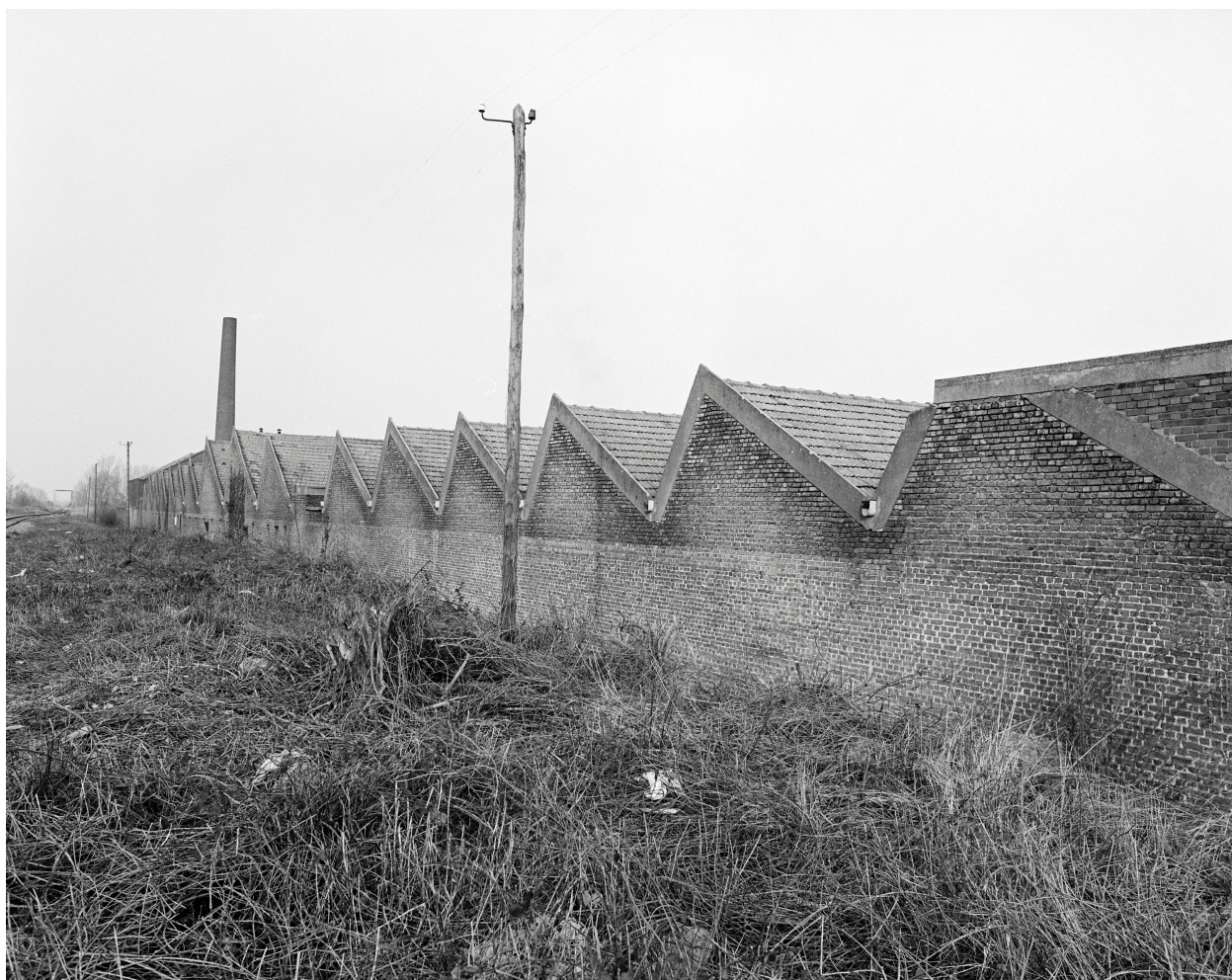
Atelier de fabrication, élévation postérieure.
