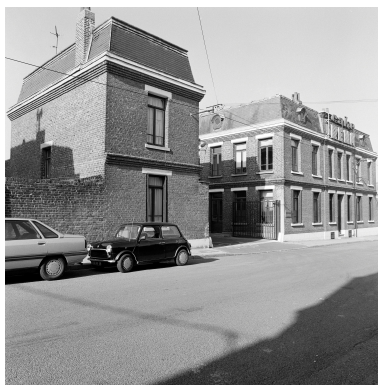
Bureaux, élévation antérieure. Phot. Olivier Marlard IVR31_19905901055X
