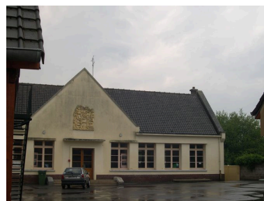
Détail sur la façade nord de l'école. Phot. Isabelle Barbedor IVR22_20038010618NUCA
