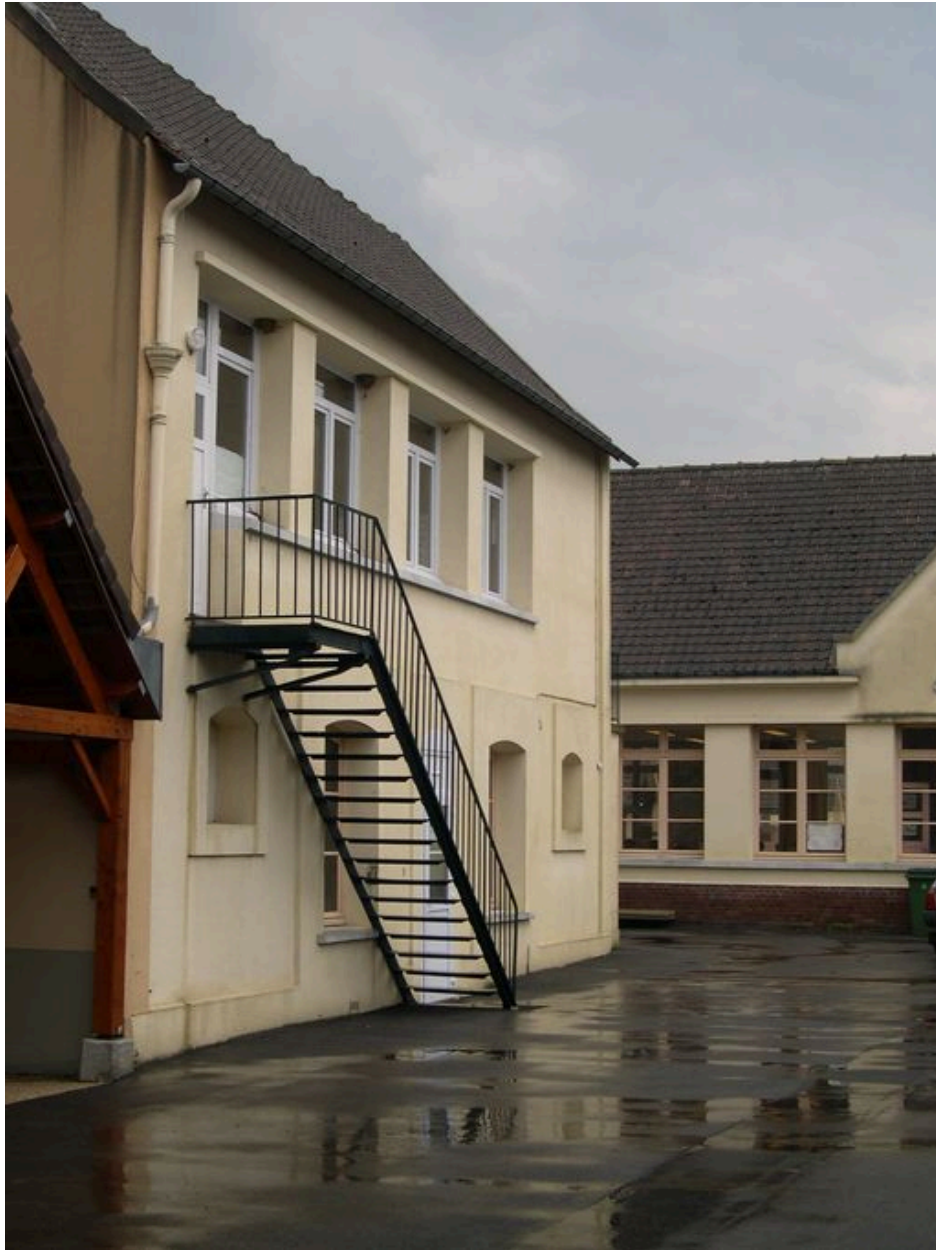
Détail sur l'ancien logement.
