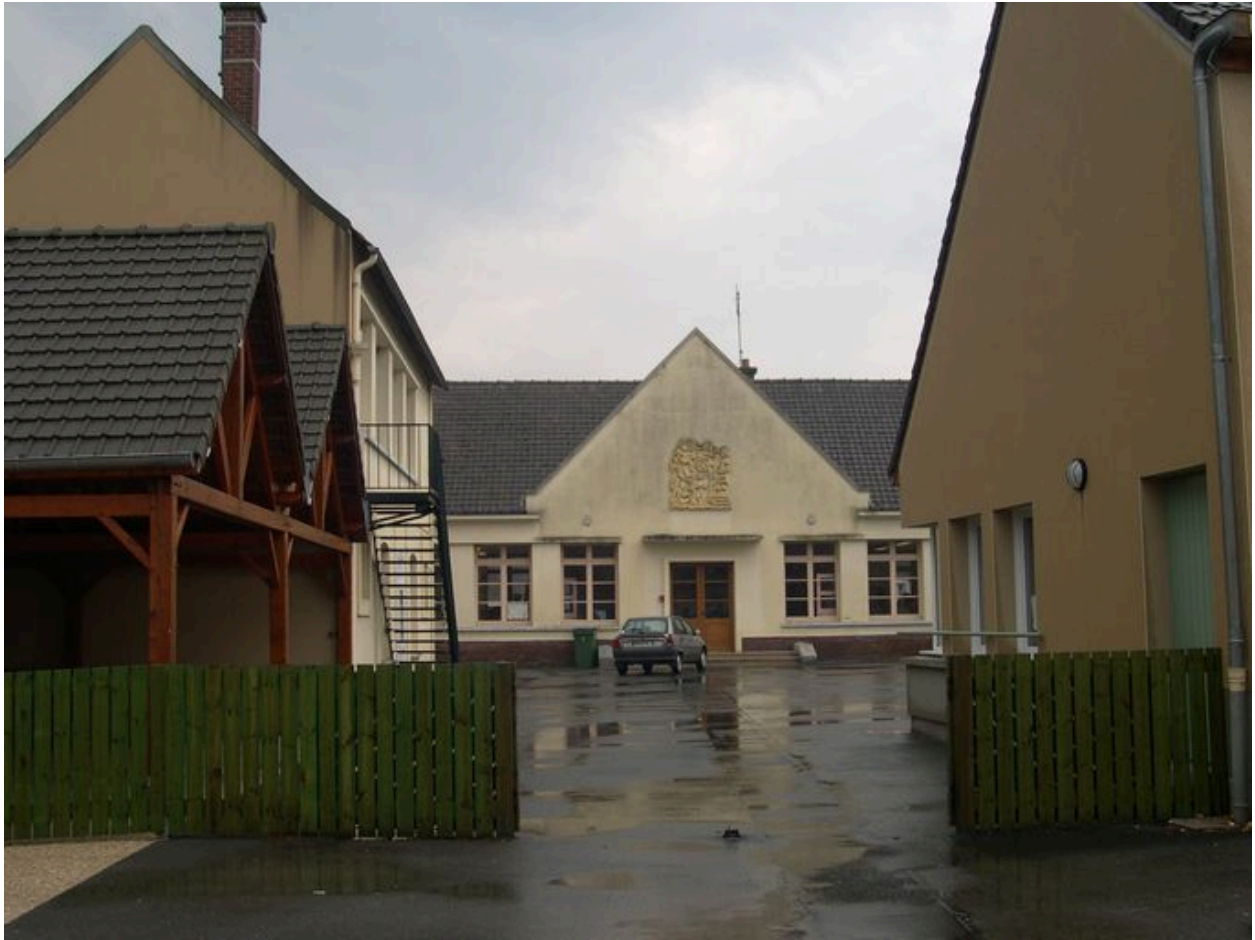
Vue de l'école, depuis le nord.
