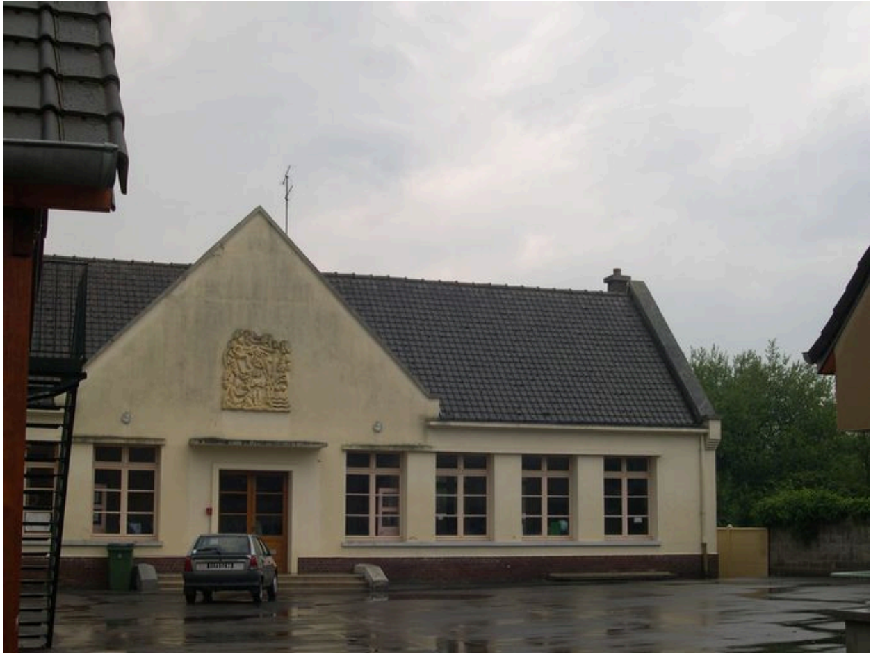
Détail sur la façade nord de l'école.
