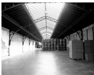
Intérieur du magasin industriel. Phot. Laurent Jumel IVR22_19966002559X
