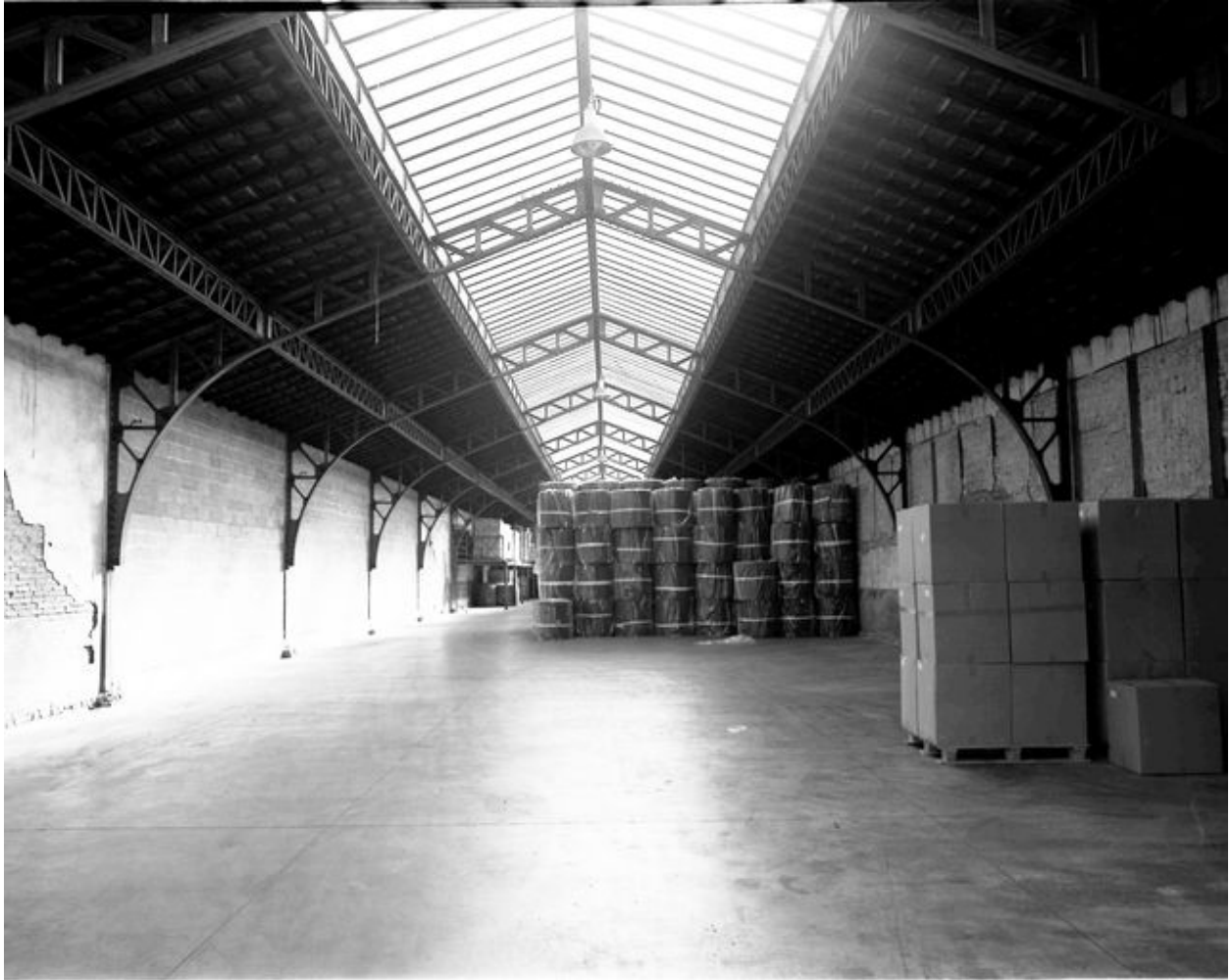
Intérieur du magasin industriel.
