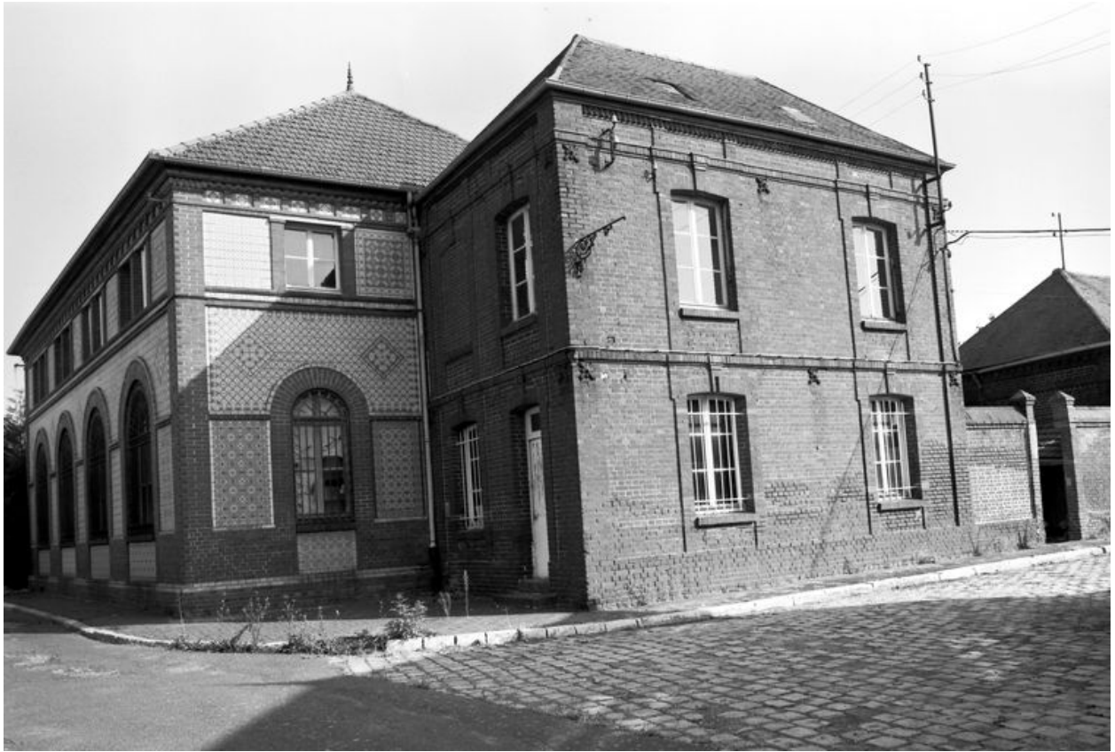
Mur sud du bureau.
