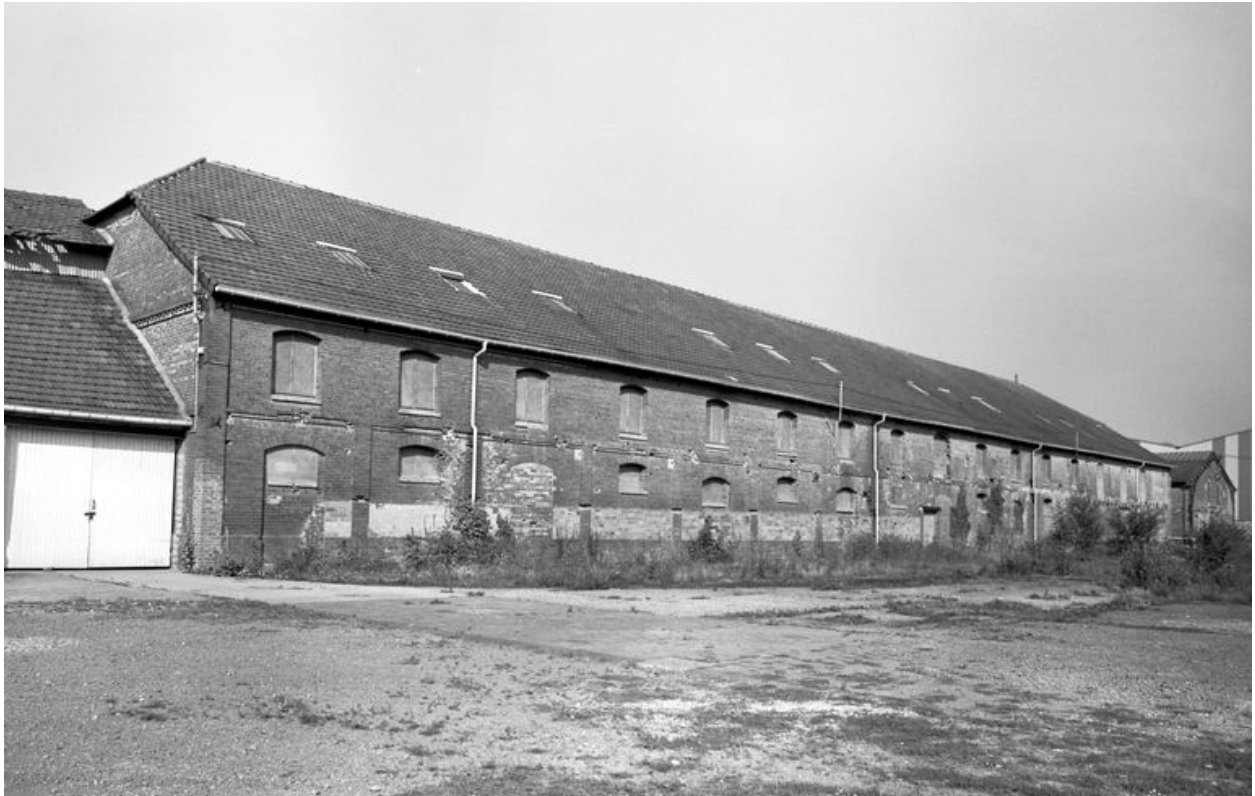
Vue longitudinale du mur ouest du four industriel construit en 1907.
