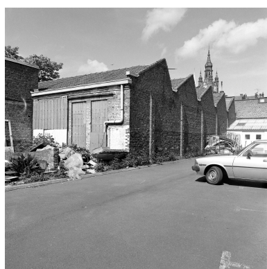
Atelier de fabrication. Phot. Philippe Dapvril IVR31_19885901186X
