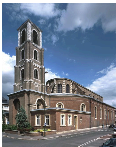
Vue générale. Phot. Thierry Lefébure IVR22_20038000768VA
