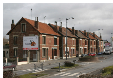
Vue générale. Phot. Frédéric Pillet IVR22_20060205003NUCA
