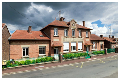
Vue de situation. Phot. Thierry Lefébure IVR32_20216000794NUCA
