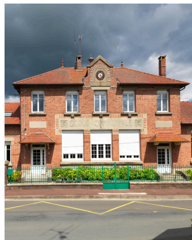
Vue du pavillon central. Phot. Thierry Lefébure IVR32_20216000796NUCA
