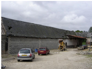
Emplacement des anciens bâtiments agricoles en torchis. Phot. Inès Guérin IVR22_20058005817NUCA
