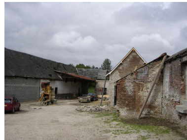
Vue des bâtiments en brique encore en place. Phot. Inès Guérin IVR22_20058005818NUCA
