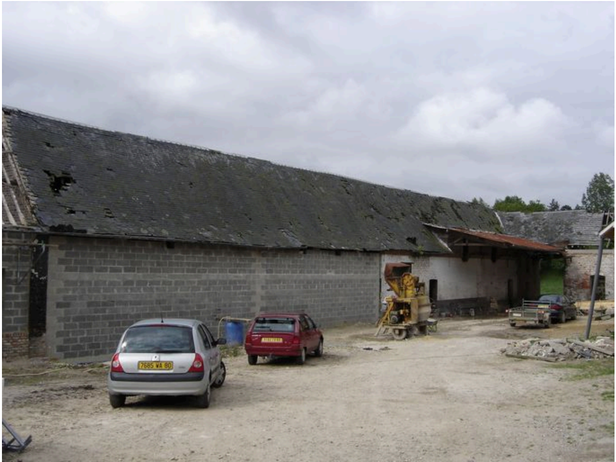
Emplacement des anciens bâtiments agricoles en torchis.
