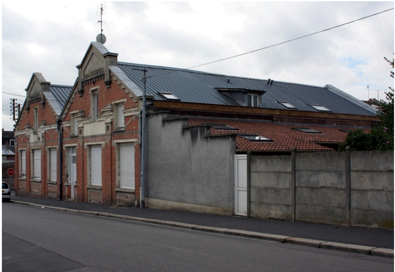
Façade antérieure des ateliers (pignons nord-est).
