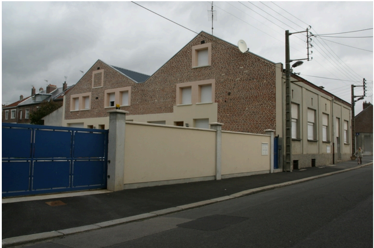
Façade postérieure des ateliers (pignons sud-ouest).
