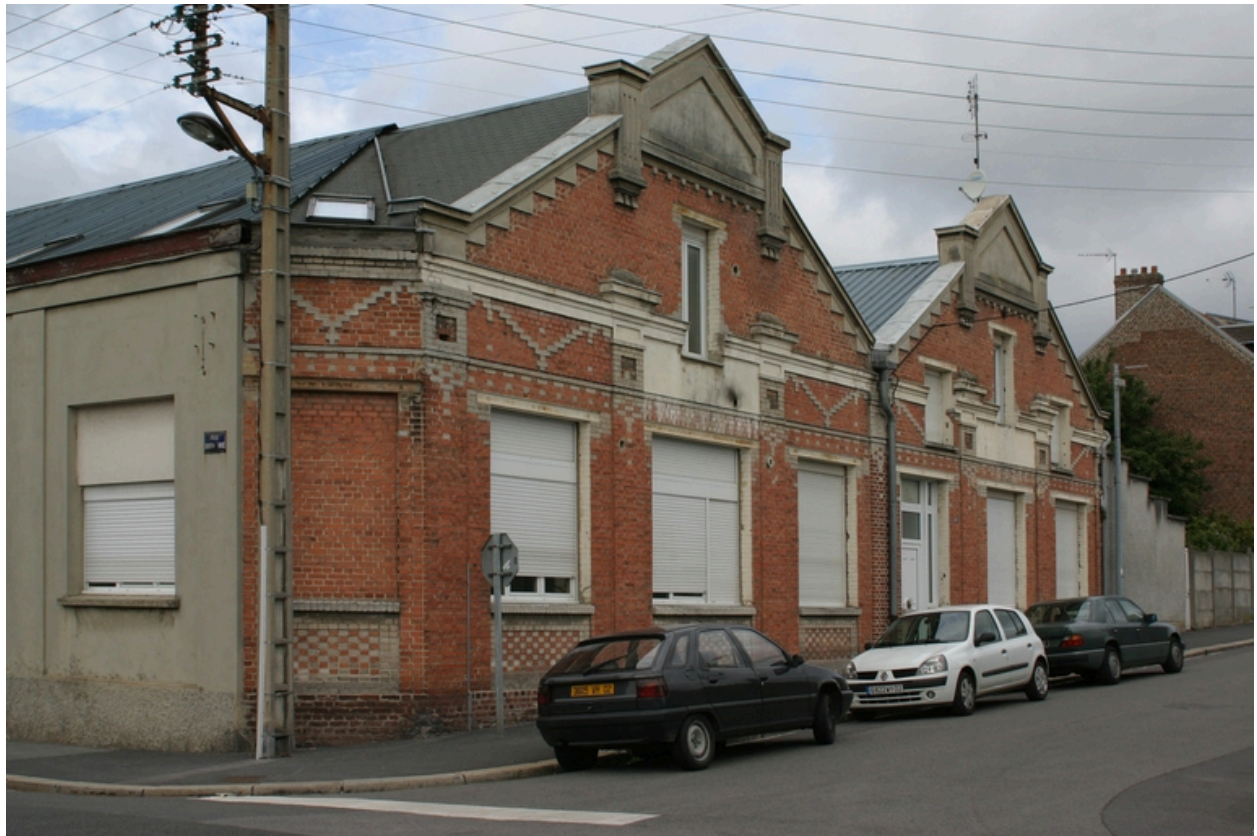
Façade antérieure des ateliers (pignons nord-est).
