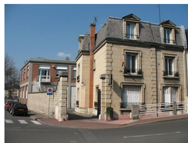
Bâtiments administratifs des établissements Willot.
