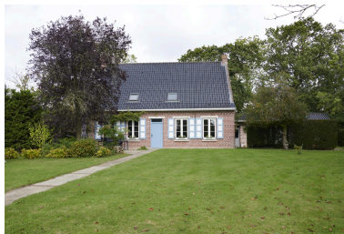
Vue générale de la façade sud. Phot. Delphine Volto Jourdan IVR32_20245903126NUCA
