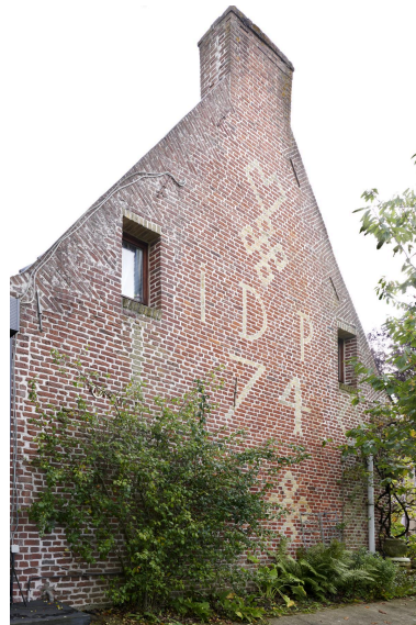
Détail du pignon ouest. Phot. Delphine Volto Jourdan IVR32_20245903128NUCA
