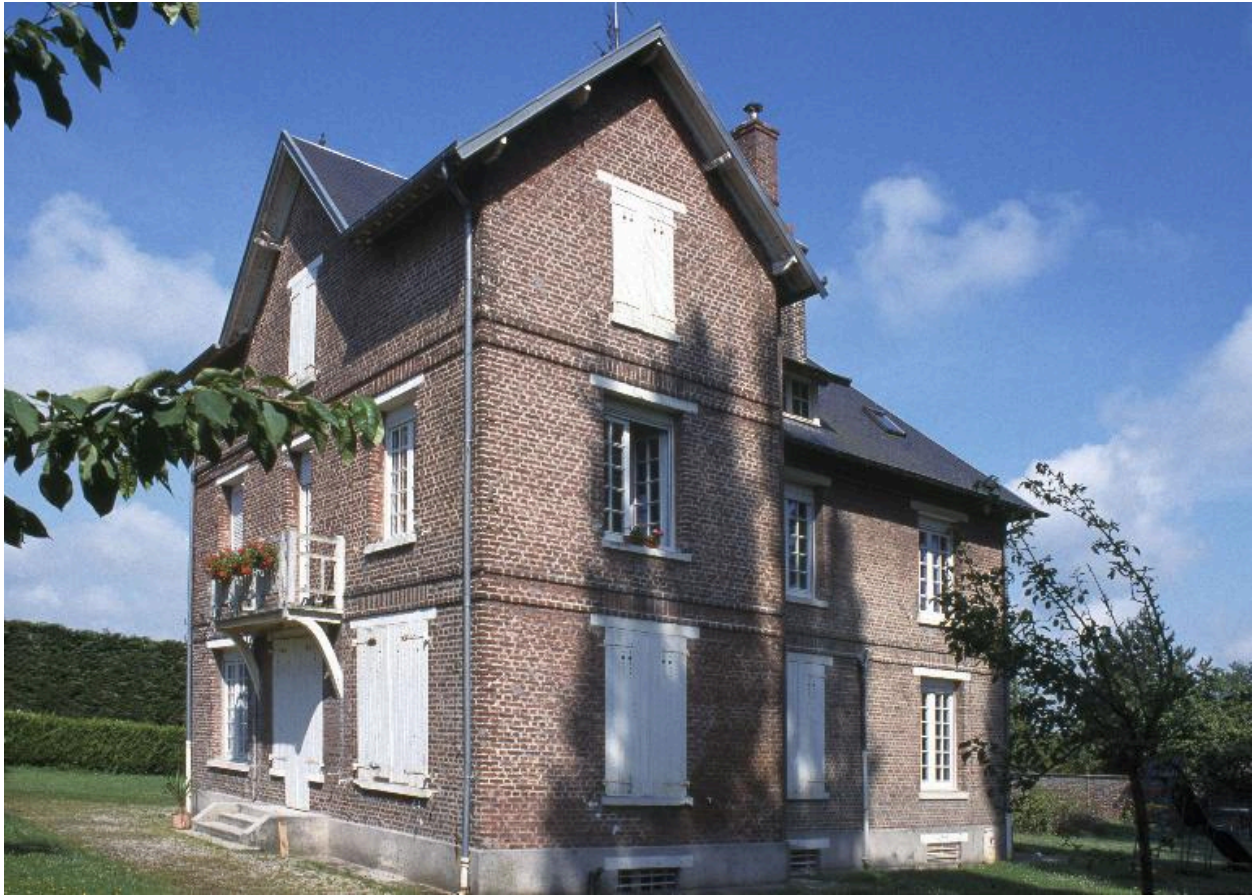
Vue d'ensemble d'un des logements de contremaîtres.
