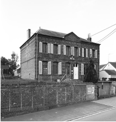
Vue générale. Phot. Thierry Lefébure IVR22_19930200484V
