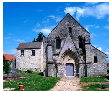
Vue extérieure de la façade occidentale. Phot. Irwin Leullier IVR22_20020202916XA
