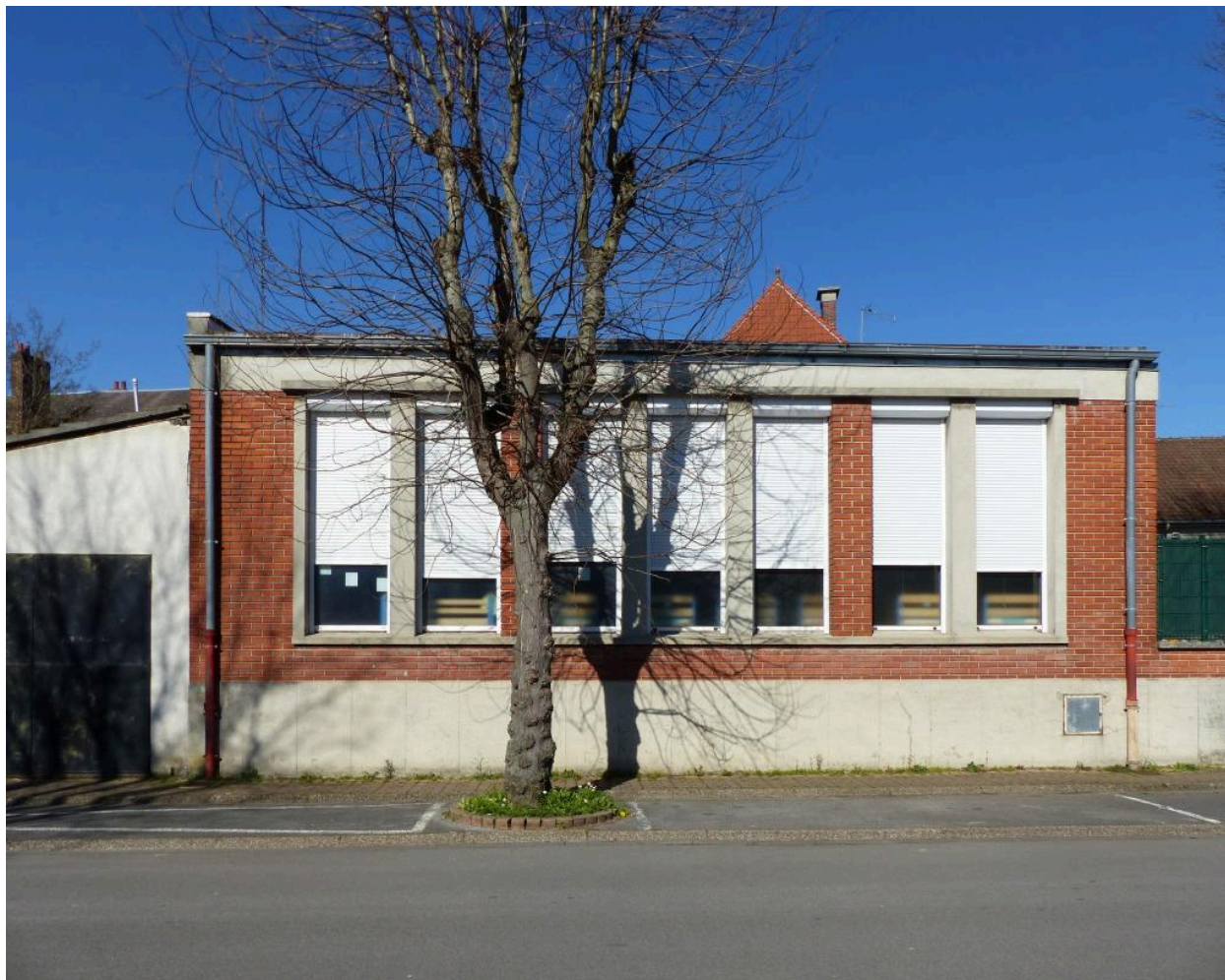
La classe construite au sud.
