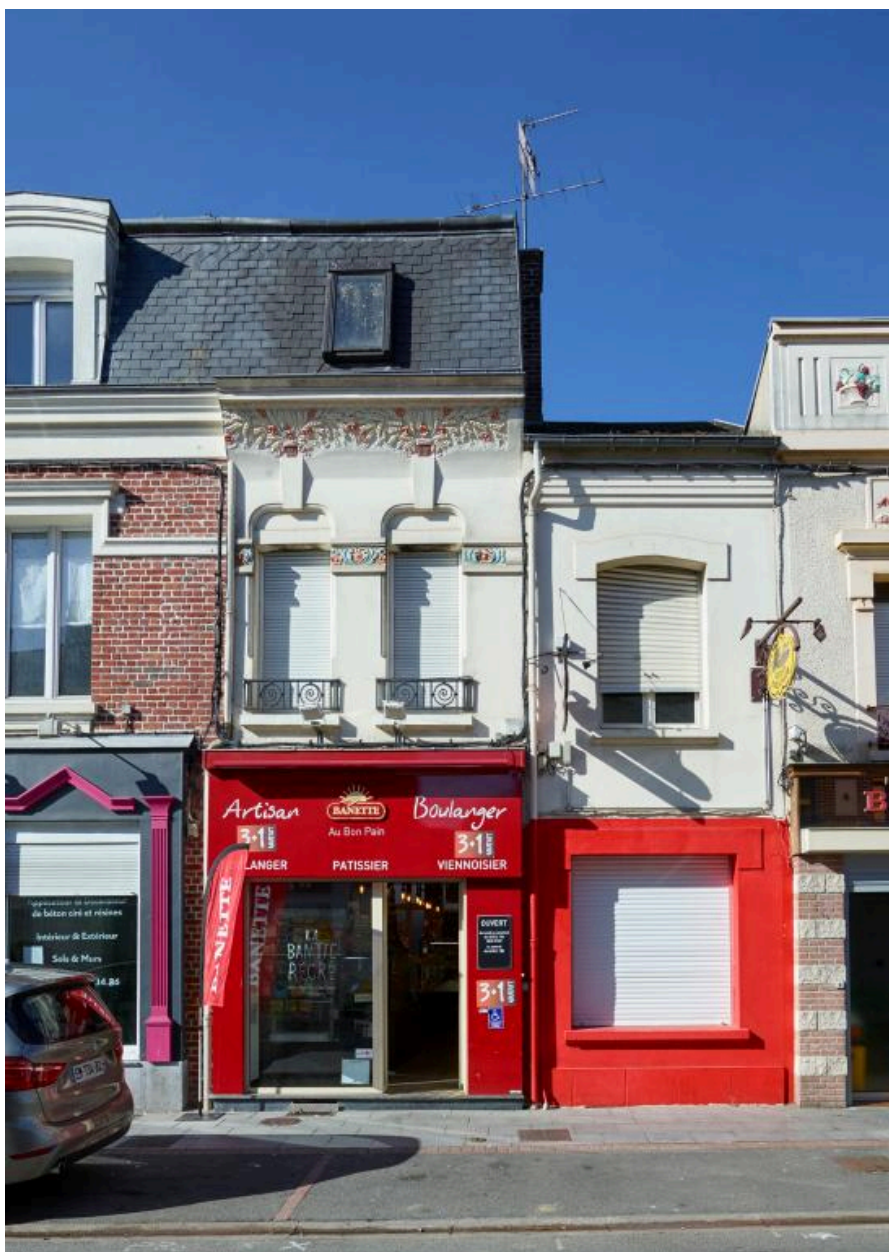
Vue générale de la façade de la boulangerie Mérienne-Flament depuis la rue de Péronne.
