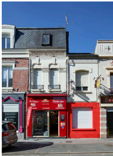
Vue générale de la façade de la boulangerie Mérienne-Flament depuis la rue de Péronne.
