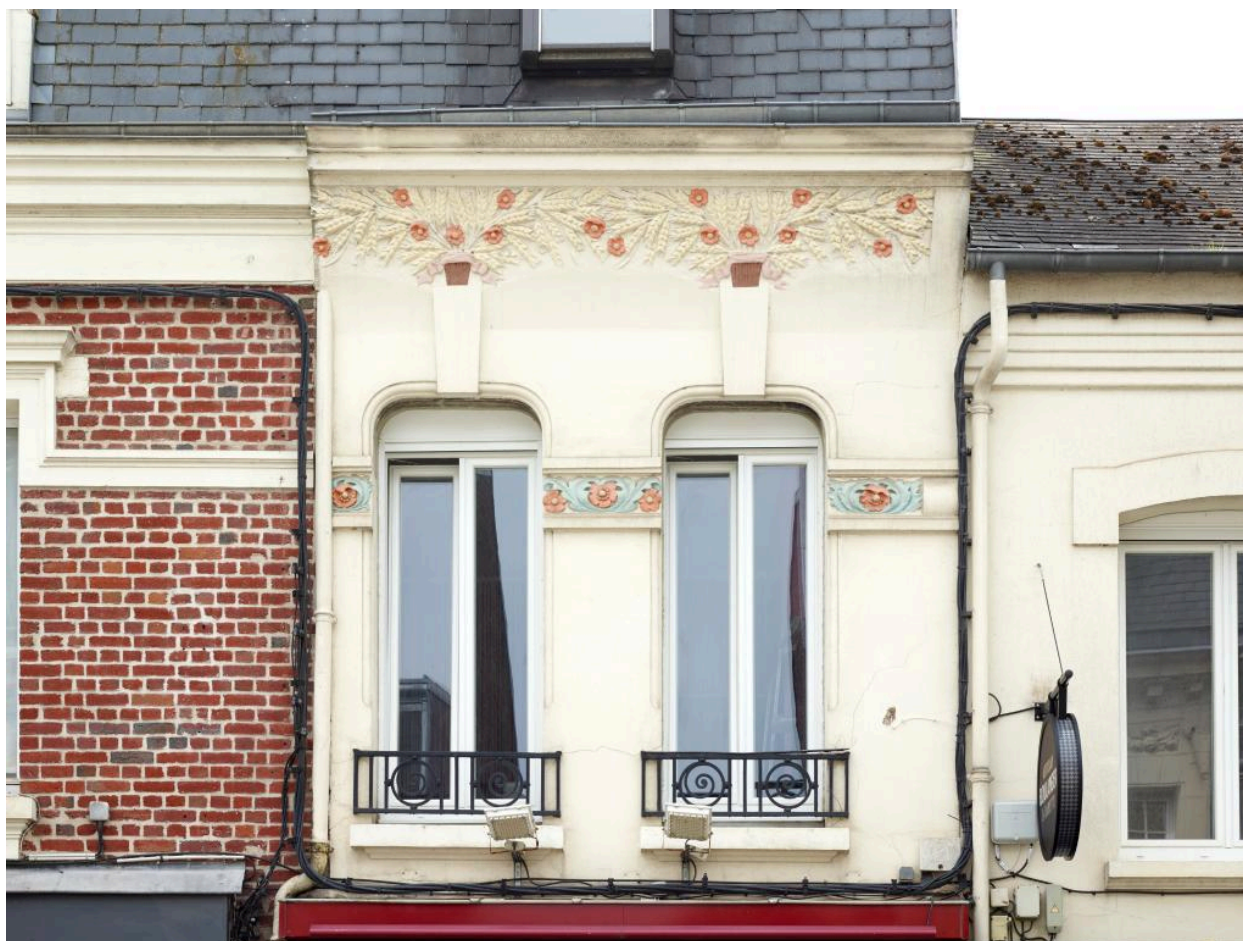
Détail du décor de la façade de la boulangerie Mérienne-Flament sur la rue de Péronne.
