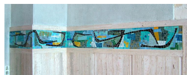
Bandeau de mosaïque courant à mi-hauteur des murs. Phot. Frédéric Fournis IVR22_20118001151NUCA
