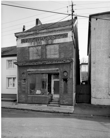
Vue générale de l'élévation antérieure.
