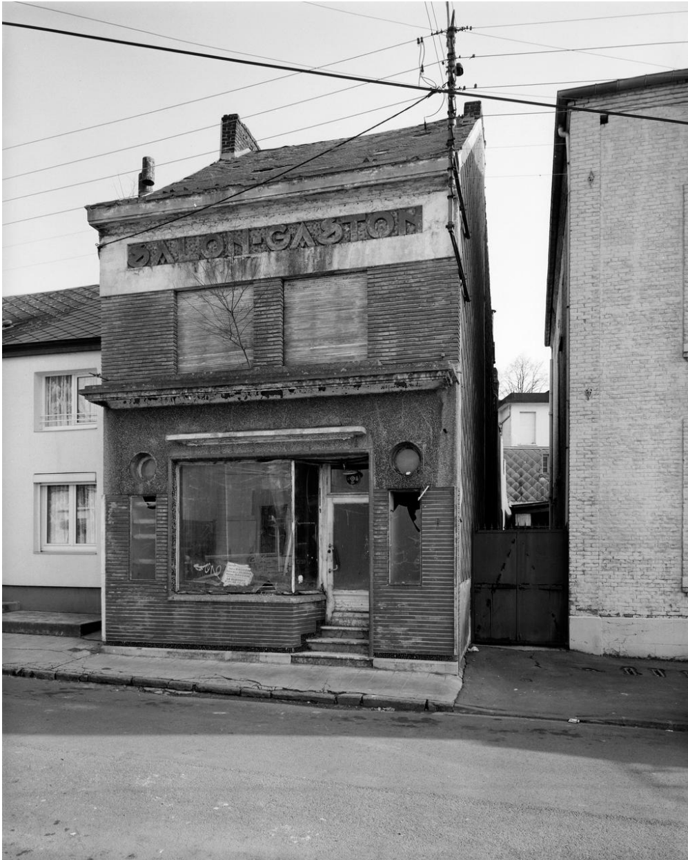
Vue générale de l'élévation antérieure.
