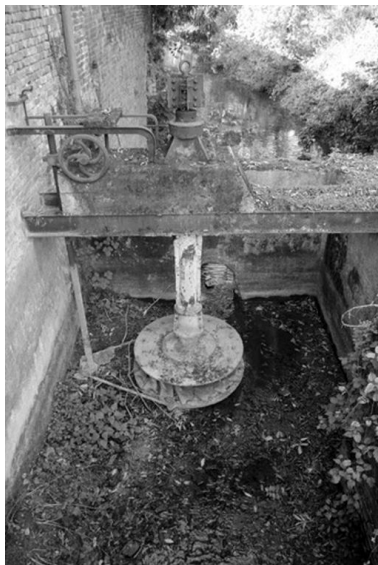
Détail de la turbine hydraulique. Phot. Benoît Dufournier IVR22_19908001606Z
