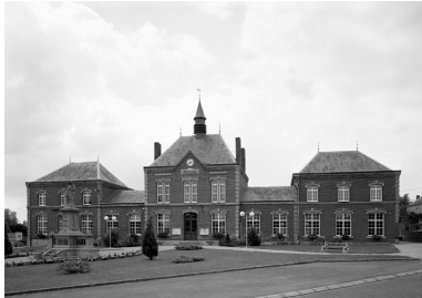
Vue générale. Phot. Thierry Lefébure IVR22_19960200559V
