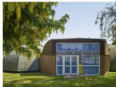
Le groupe scolaire Chateaubriand (quartier le Château). Phot. Pierre Thibaut IVR32_20185900040NUCA
