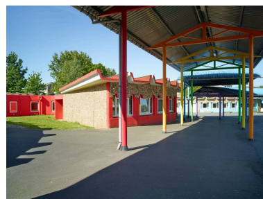
Le collège Le Triolo (quartier le Triolo). Phot. Pierre Thibaut IVR32_20175900871NUCA
