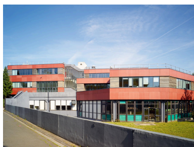
Le lycée Raymond-Queneau (quartier le Pont-de-Bois). Phot. Pierre Thibaut IVR32_2019590009NUCA
