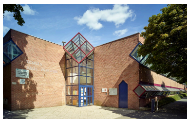
Le groupe scolaire Paul-Verlaine (quartier l'Hôtel-de-Ville). Phot. Pierre Thibaut IVR32_20195901002NUCA
