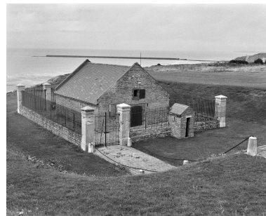
Vue d' angle nord. Phot. Philippe Dapvril IVR31_19936200900X
