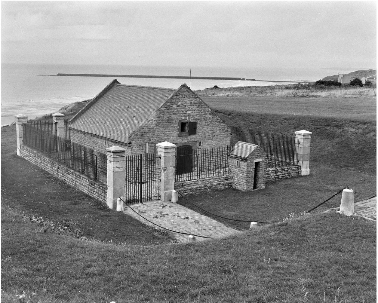
Vue d' angle nord.
