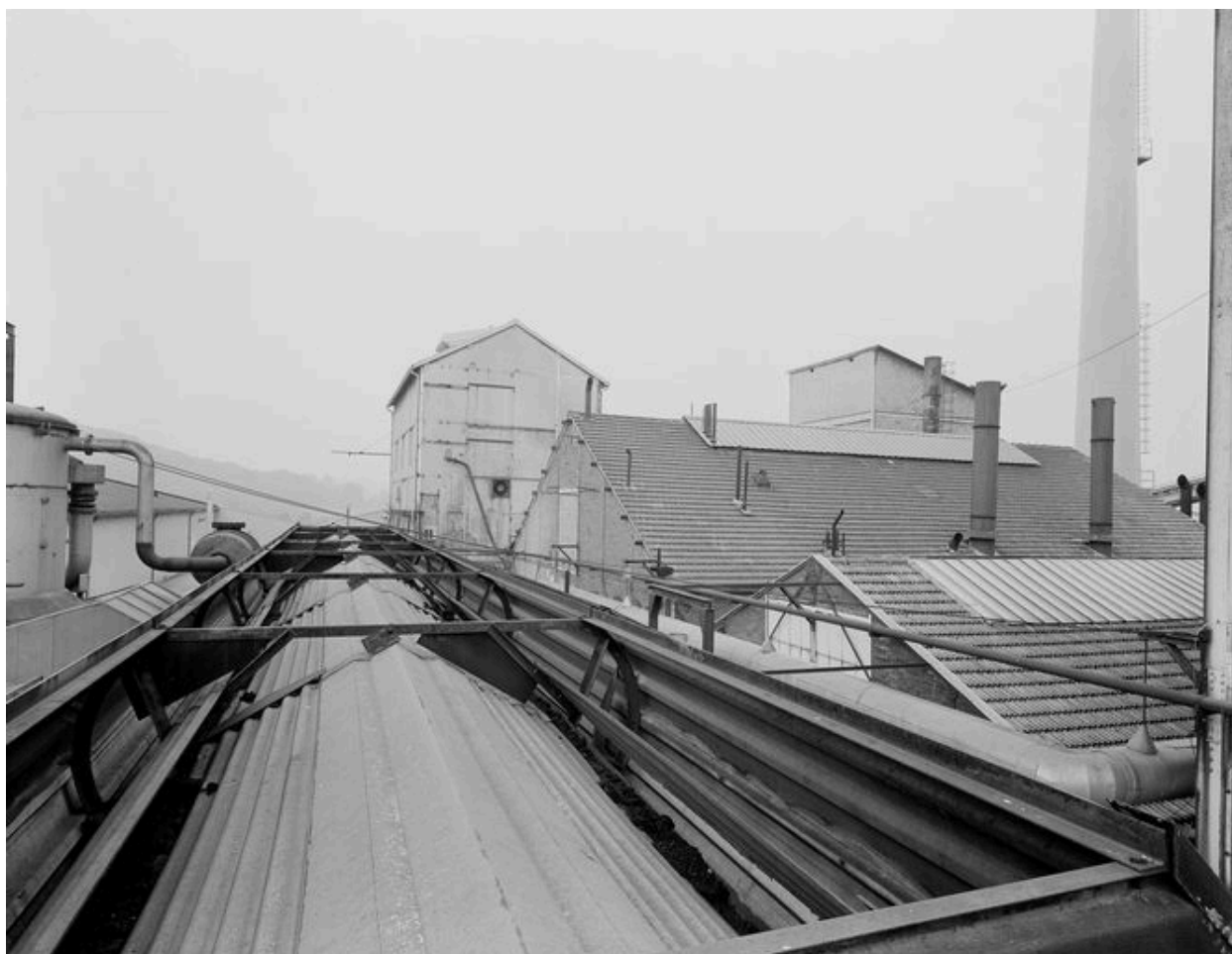
Vue générale des chaufferies (toitures).
