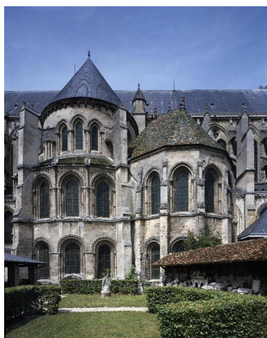
Vue extérieure du bras sud du transept et de la chapelle attenante.
