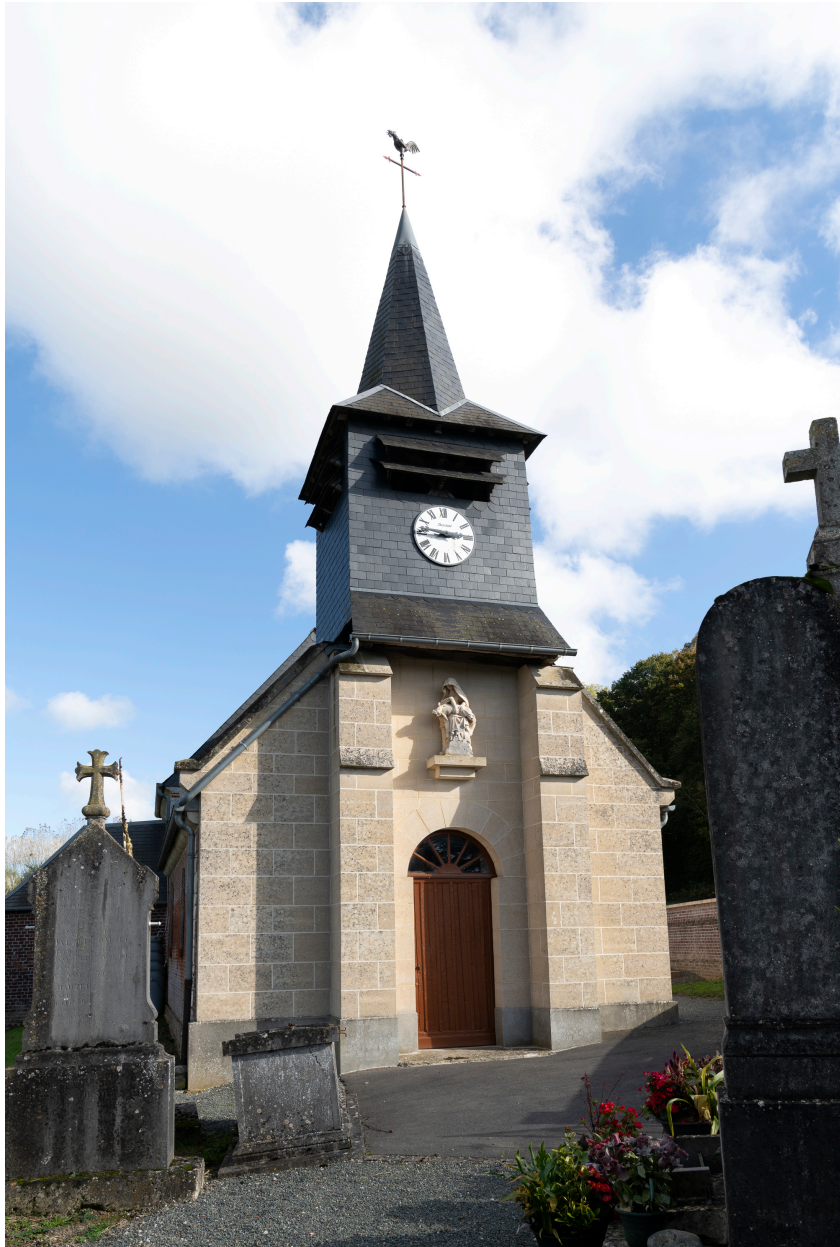
Vue générale de la façade occidentale.
