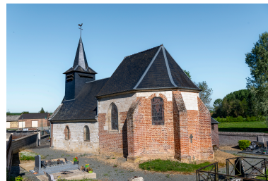
Vue générale de l'église depuis le sud-est. Phot. Marc Kérignard IVR32_20256000244NUCA
