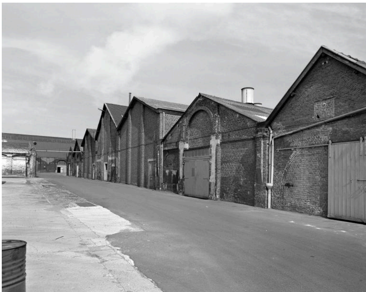
Vue extérieure des bâtiments industriels.
