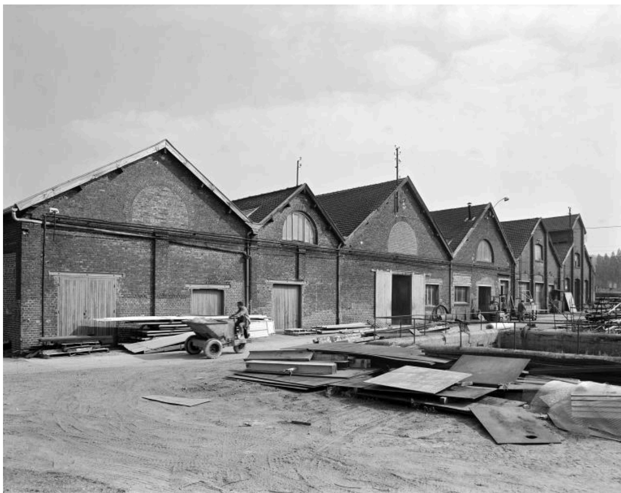
Vue extérieure des bâtiments industriels.
