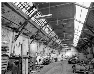
Vue intérieure d'un entrepôt industriel.
