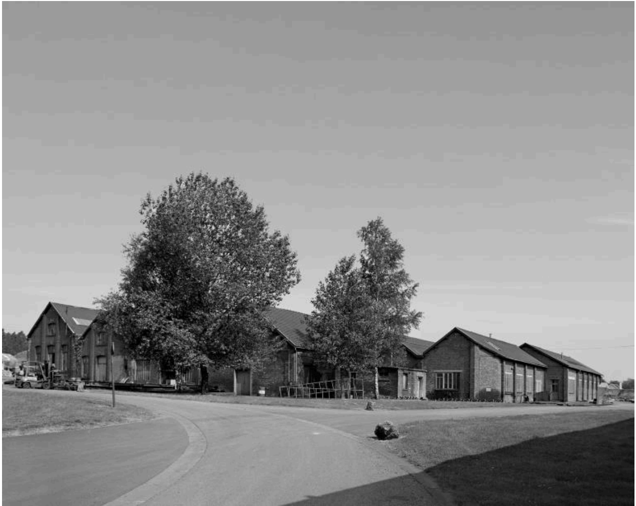
Vue extérieure des bâtiments industriels.
