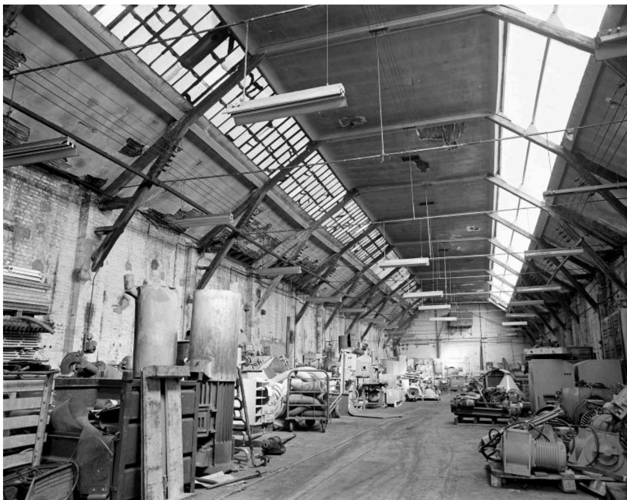
Vue intérieure d'un entrepôt industriel.
