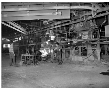
Vue de 2 cubillots de fours, dont un en cours de coulée.
