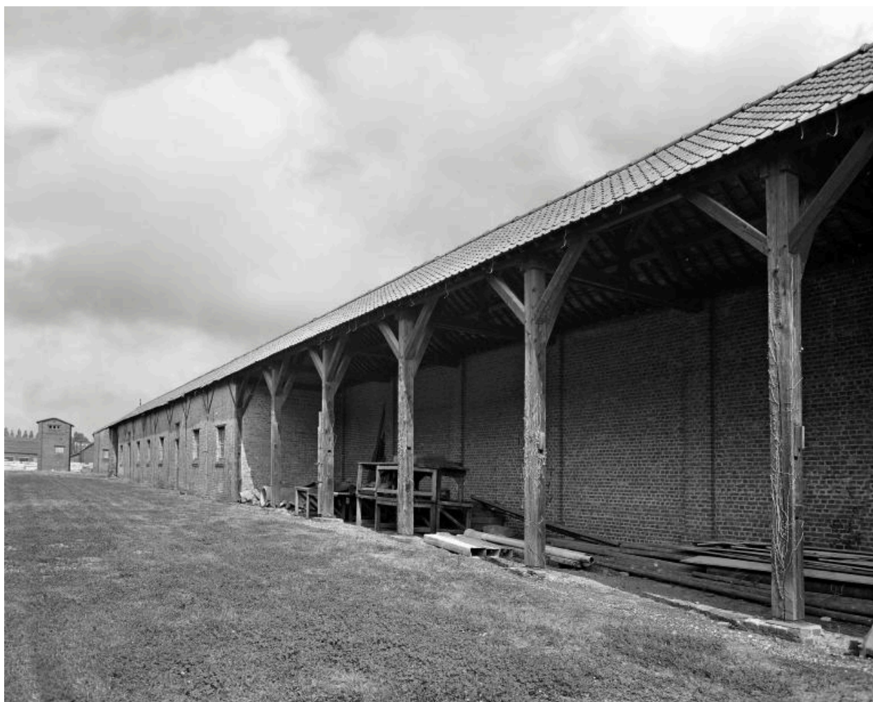
Vue d'un entrepôt et d'un hangar industriels.
