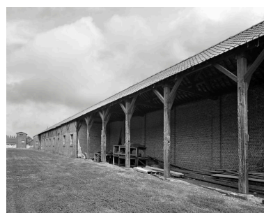
Vue d'un entrepôt et d'un hangar industriels.
