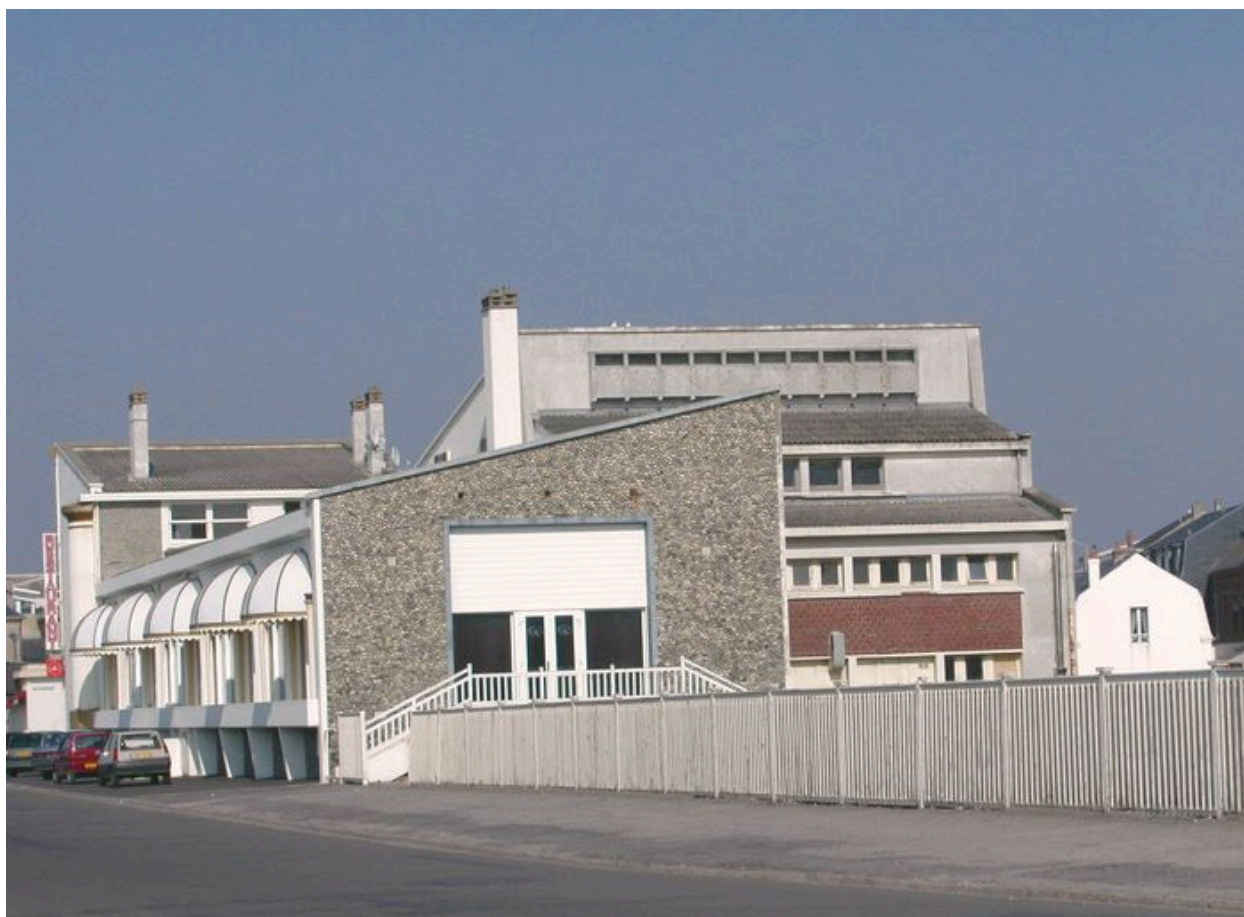
Parement de galets sur le casino de Cayeux-sur-Mer, vue actuelle.
