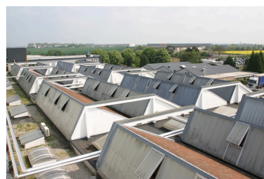
Les sheds des ateliers de 1929.
