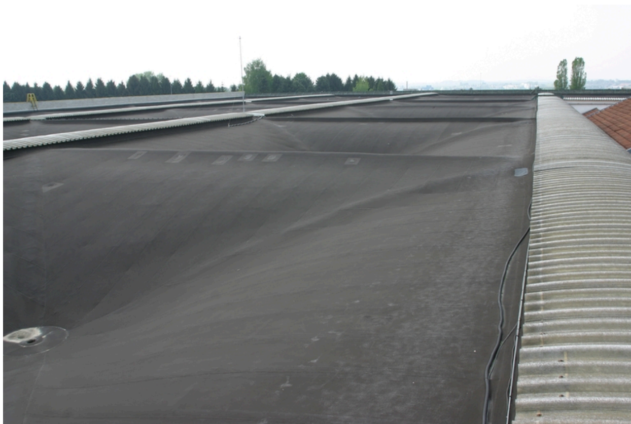
Toiture des entrepôts et magasins de 1966.
