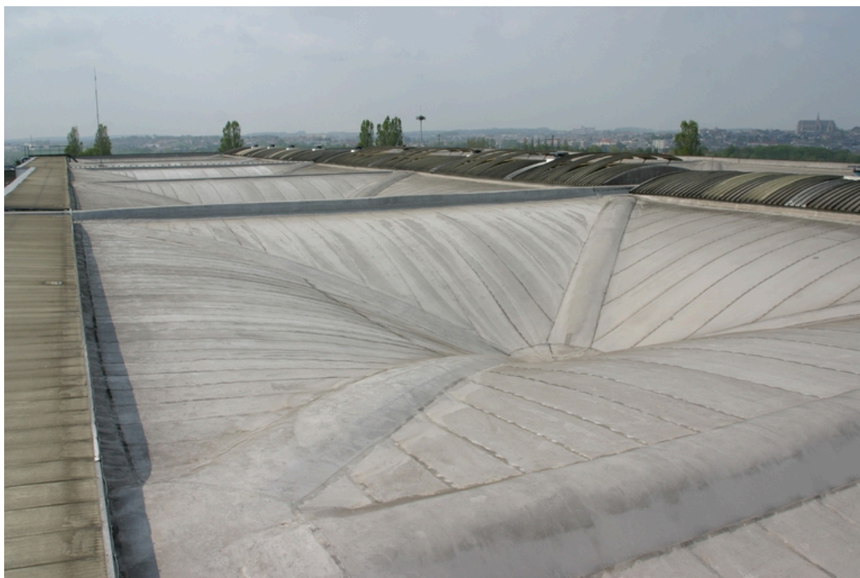
Toiture des ateliers de 1967.
