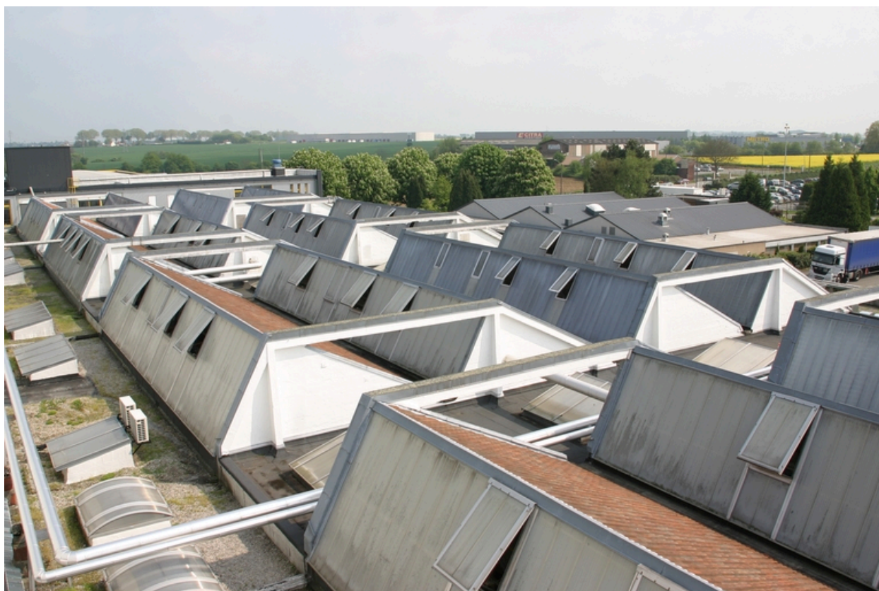
Les sheds des ateliers de 1929.
