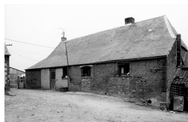
Elévation arrière du logis. Phot. Thierry Lefébure IVR22_19920201071Z
