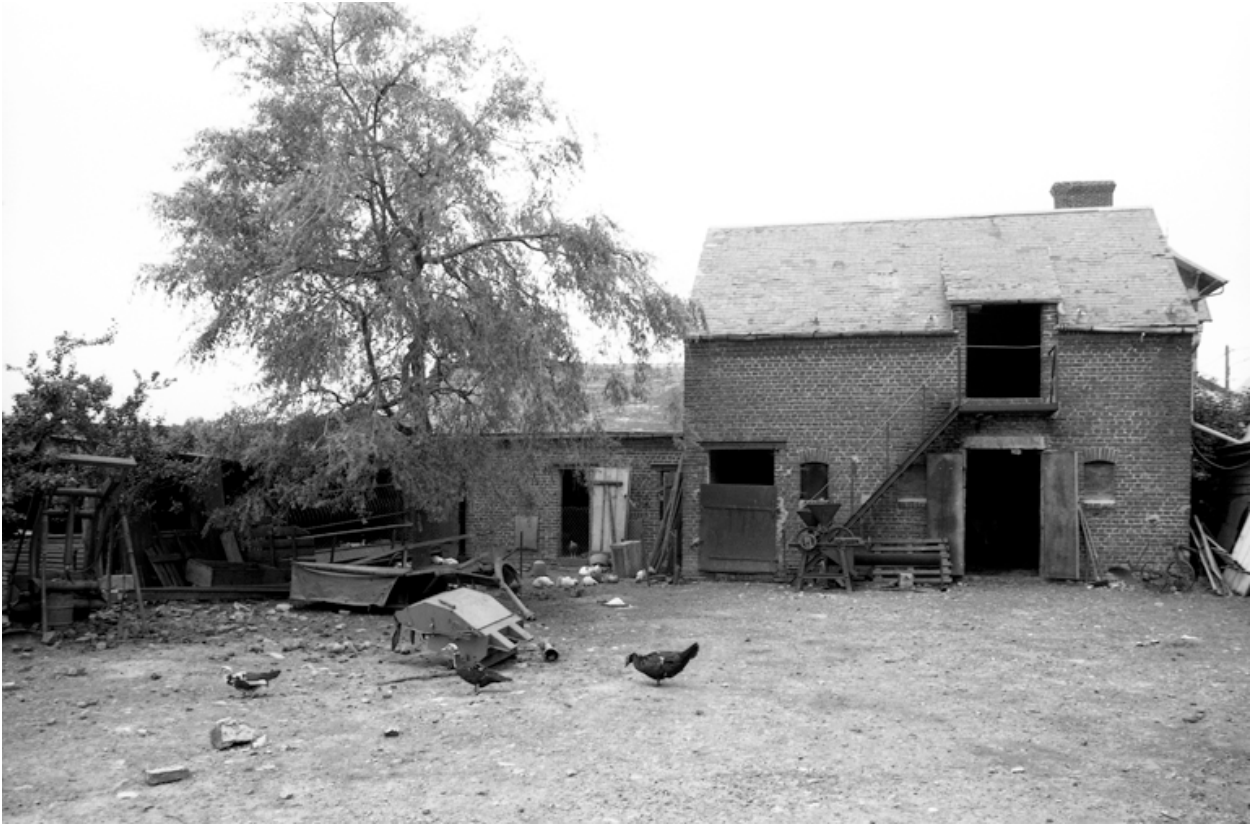
Elévation sur cour de l'étable nord.
