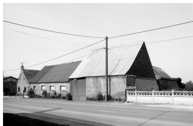
Vue d'ensemble depuis le nord-est. Phot. Thierry Lefébure IVR22_19920201149Z
