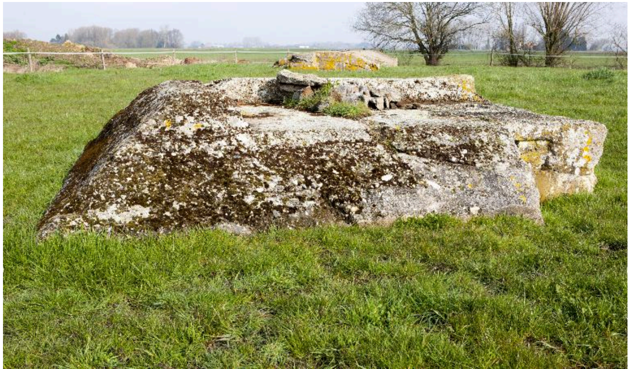
Casemate sud, vers le nord-ouest
