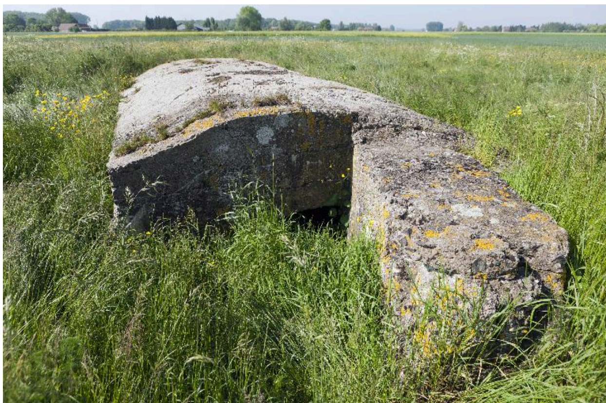
Casemate nord, entrée nord
