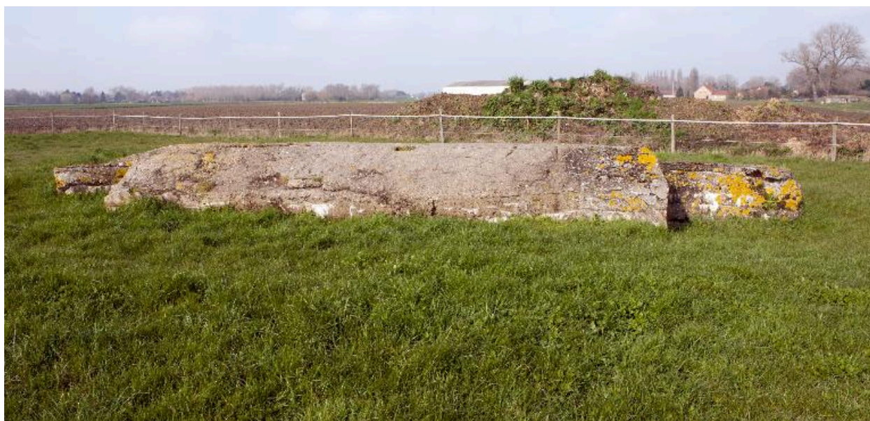
Casemate nord, vue vers l'ouest
