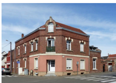
Maison, 14 rue de Melbourne. Phot. Isabelle Barbedor IVR32_20208005052NUCA
