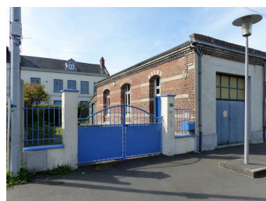
Ancienne poste de Villers- Bretonneux, rue Arsène-Obry. Phot. Isabelle Barbedor IVR32_20208005058NUCA
