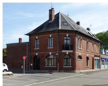
Maison de commerce, La Ruche, 2 rue Général-Leclerc. Phot. Isabelle Barbedor IVR32_20208005053NUCA
