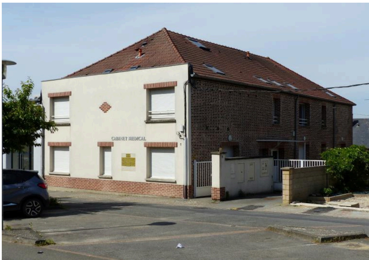
Ancien cinéma, dit Modern Cinéma, rue de la République.
