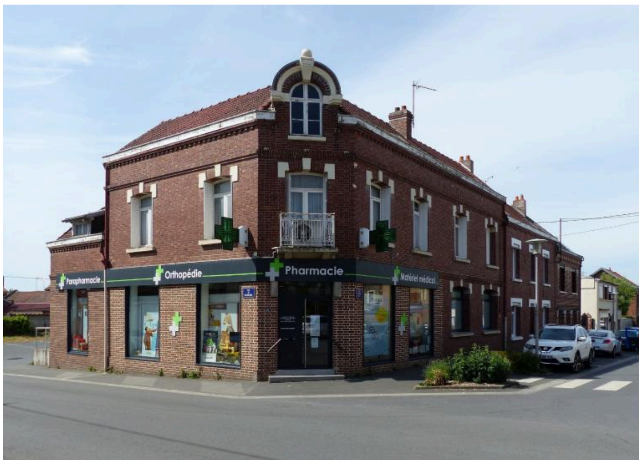
Maison de commerce (pharmacie), 12 rue de Melbourne. L'édifice est reconstruit à l'emplacement de l'ancienne fabrique de gilets de chasse Decaix-Allou.
