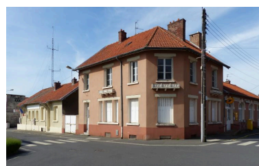
L'ancienne école primaire de filles, rue Arsène-Obry (ancienne Grande-rue), reconstruite après la première guerre mondiale. Phot. Isabelle Barbedor IVR32_20208005034NUCA
