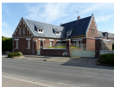
Maison ancienne ferme ?, 1 rue de la Gare. Phot. Isabelle Barbedor IVR32_20208005050NUCA
