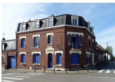
Maison, 2 rue de la Gare. Phot. Isabelle Barbedor IVR32_20208005051NUCA
