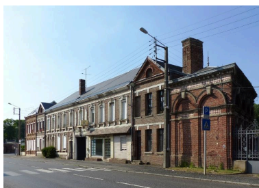
ancienne fabrique Postel-Dubois, puis usine Delaux-Châtel, route de Péronne. Phot. Isabelle Barbedor IVR32_20168005763NUCA
