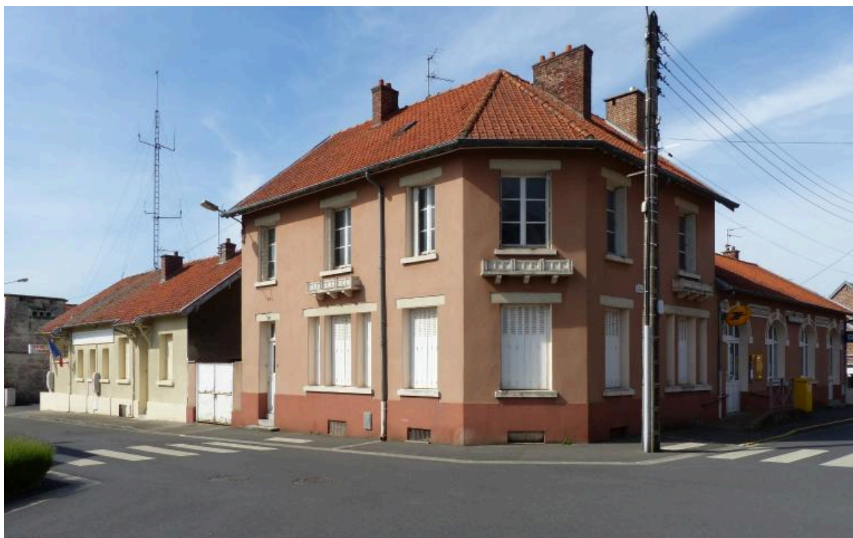
L'ancienne école primaire de filles, rue Arsène-Obry (ancienne Grande-rue), reconstruite après la première guerre mondiale.
