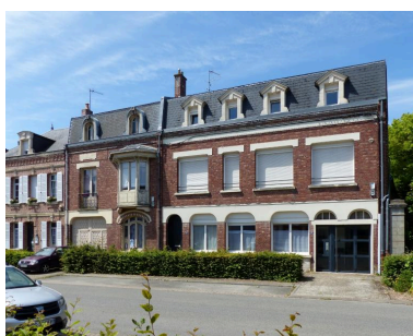
L'ancien Hôtel Central. Rue des Tavernes. Phot. Isabelle Barbedor IVR32_20208005143NUCA
