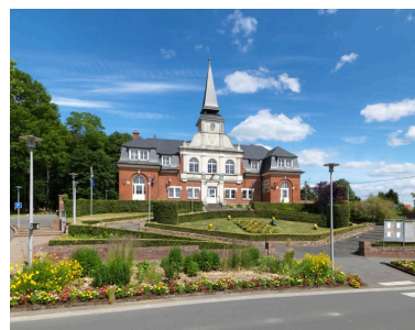
L'hôtel de ville de Villers-Bretonneux, reconstruit de 1926 à 1928, sur les plans de l'architecte André Guilbert, à l'emplacement de l'ancien château, et inauguré en 1929. Phot. Thierry Lefébure IVR32_20208000106NUC2A
