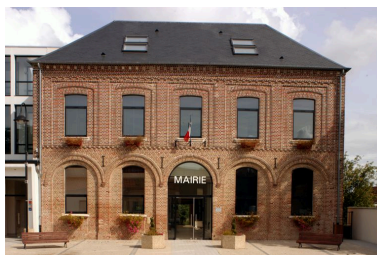
Vue de la façade sud.
