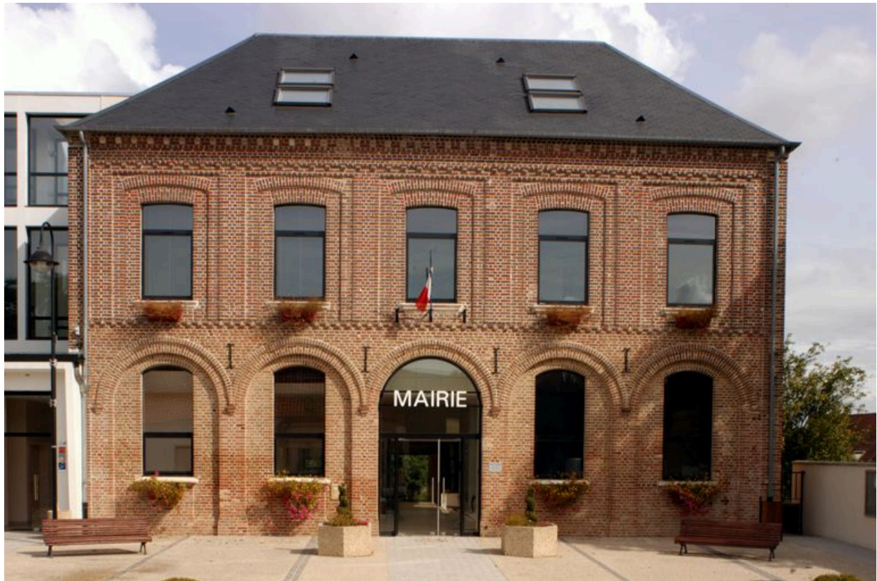
Vue de la façade sud.
