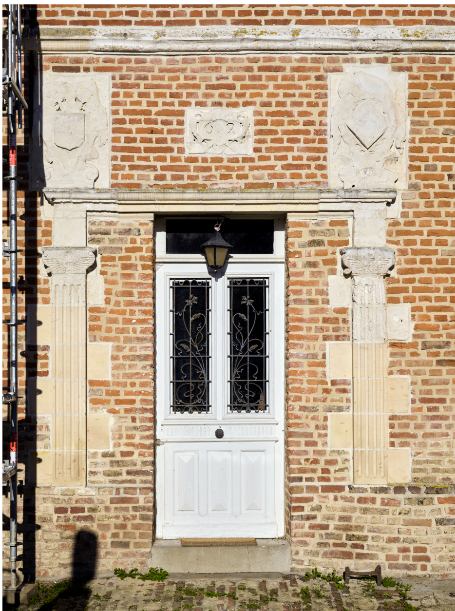
Porte principale, façade sur cour.
