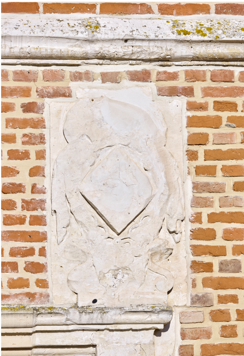
Détail de l'armoire de droite, porte principale.
