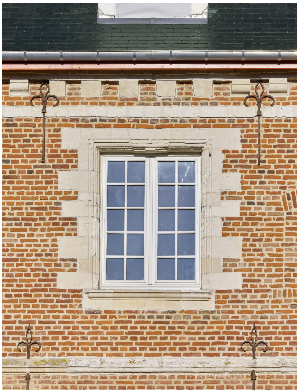
Détail d'une des fenêtres de l'étage, façade sur cour.
