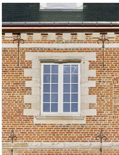
Détail d'une des fenêtres de l'étage, façade sur cour. Phot. Thierry Lefébure IVR32_20258000797NUCA
