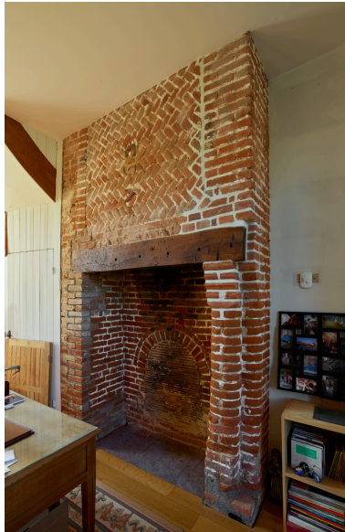
Cheminée, intérieur du manoir. Phot. Thierry Lefébure IVR32_20258000806NUCA
