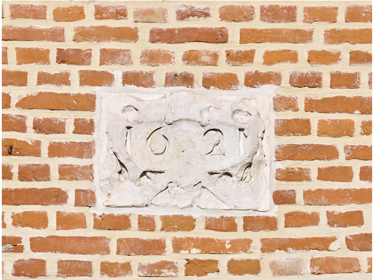
Détail de la date portée, porte principale.
