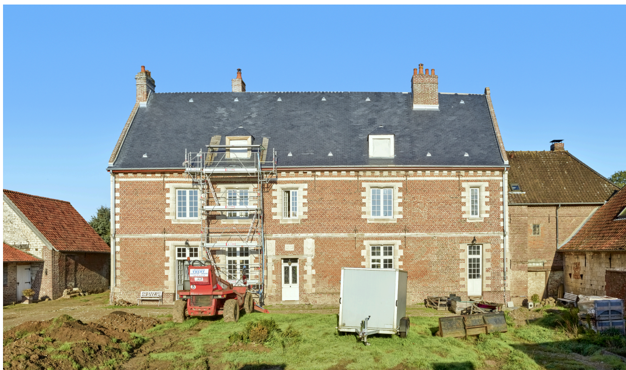
Façade sur cour.
