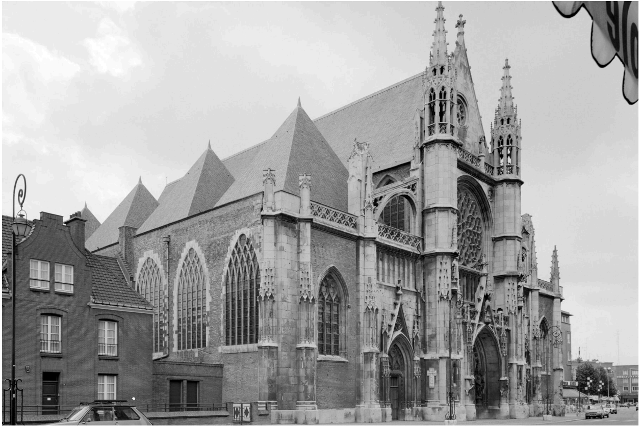
Vue générale d'angle nord-ouest.
