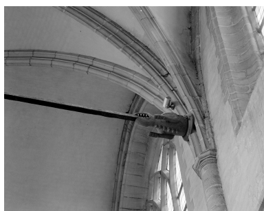
Nef, détail : 6e travée, engoulant sud et départ de voûtes. Phot. Jean-Michel Périn IVR31_19885901578X
