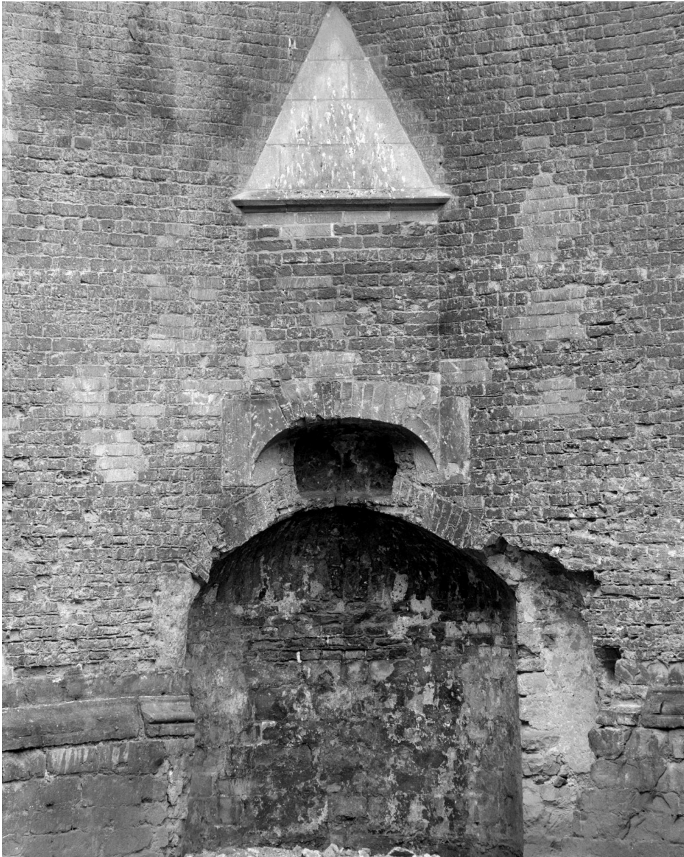
Chevet, détail : niche entre les deux chapelles sud.
