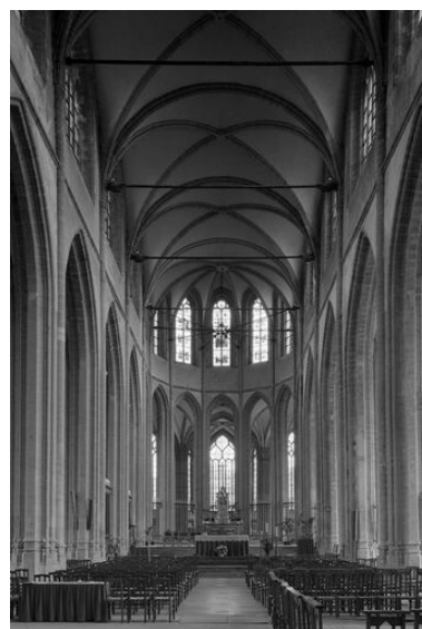
Vue générale de la nef vers l'est.
