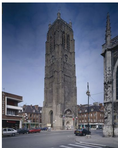
Tour-beffroi, vue générale sud-est. Phot. Philippe Dapvril IVR31_19945900644VA
