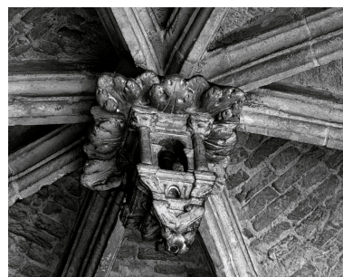
Grande sacristie, voûtement, détail : clef pendante. Phot. Jean-Michel Périn IVR31_19885901486X
