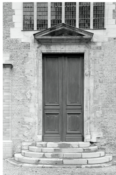
Façade sud, détail : porte. Phot. Jean-Michel Périn IVR31_19885901636X
