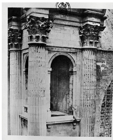
Péristyle, 1ère travée de droite, partie supérieure. Repro. Jean-Michel Périn IVR31_19875903532XB
