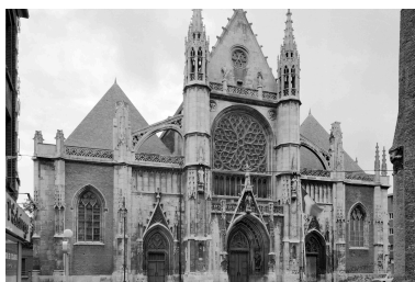
Vue générale de la façade ouest. Phot. Jean-Michel Périn IVR31_19865901707X
