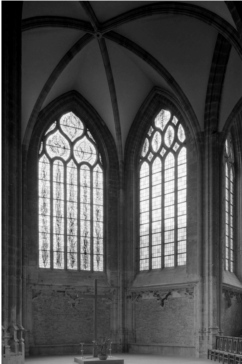
Première chapelle rayonnante au sud de la chapelle axiale : vue générale depuis le nord-ouest.
