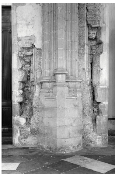
2e bas-côté nord : base du 5e pilier engagé, sondages. Phot. Jean-Michel Périn IVR31_19885901502X
