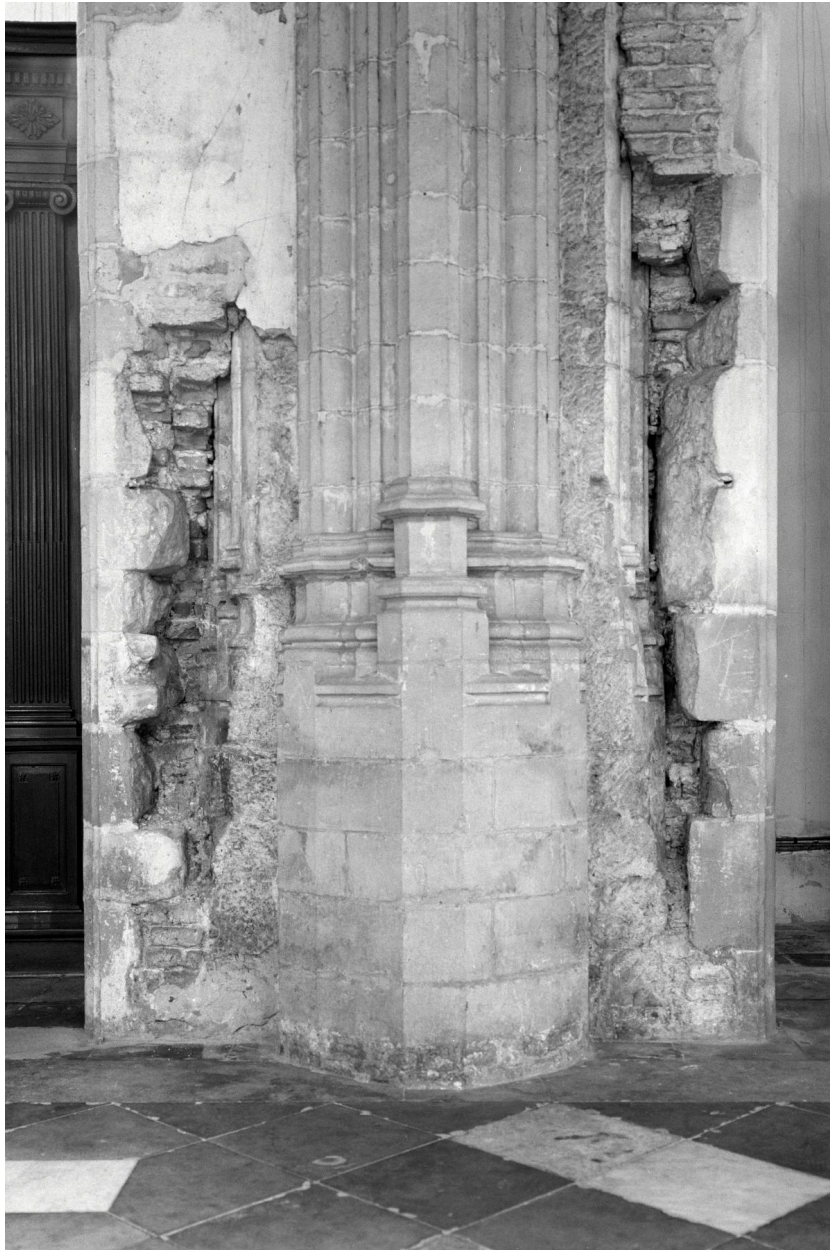
2e bas-côté nord : base du 5e pilier engagé, sondages.
