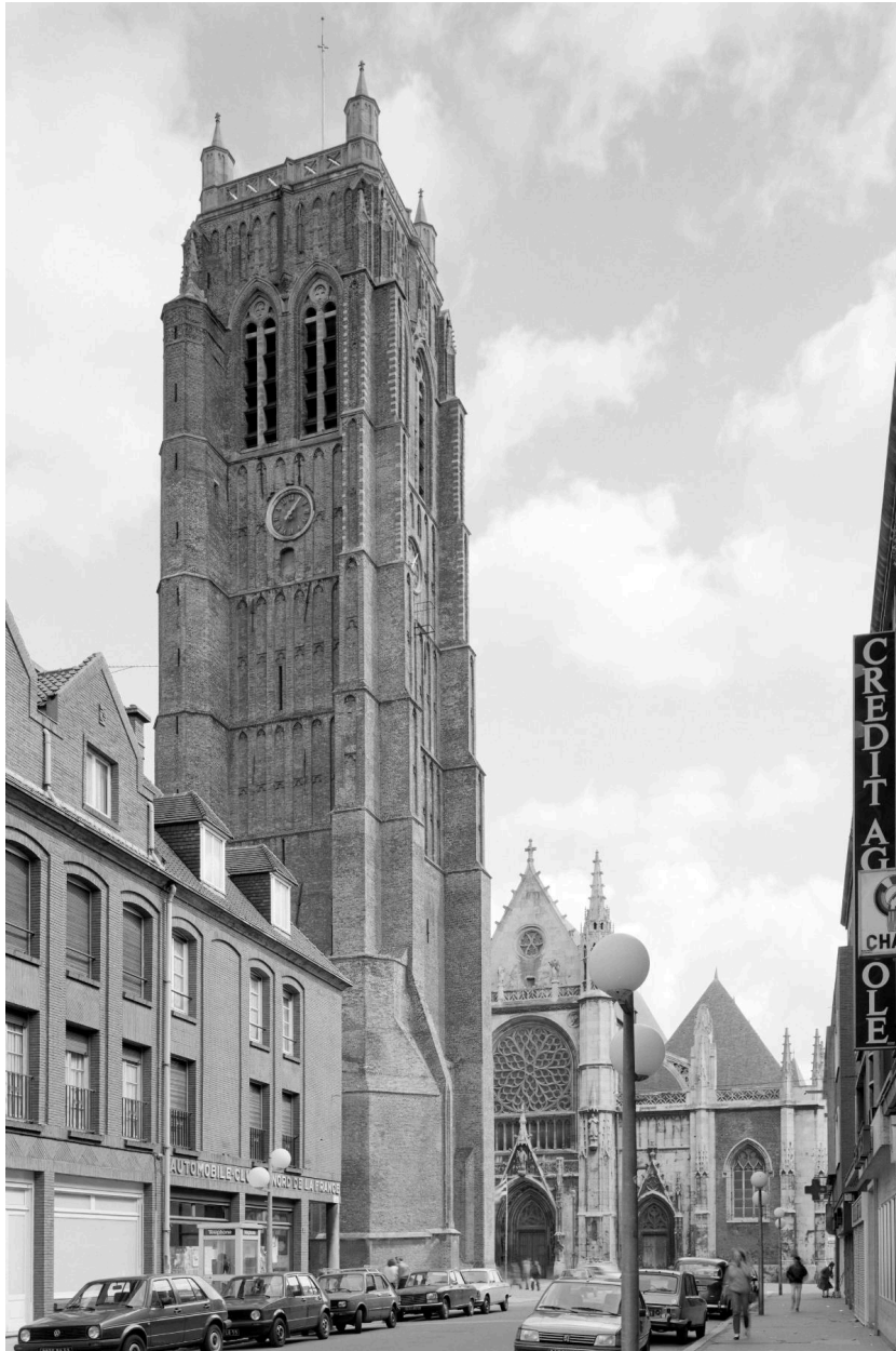
Tour-beffroi, vue générale sud-ouest.
