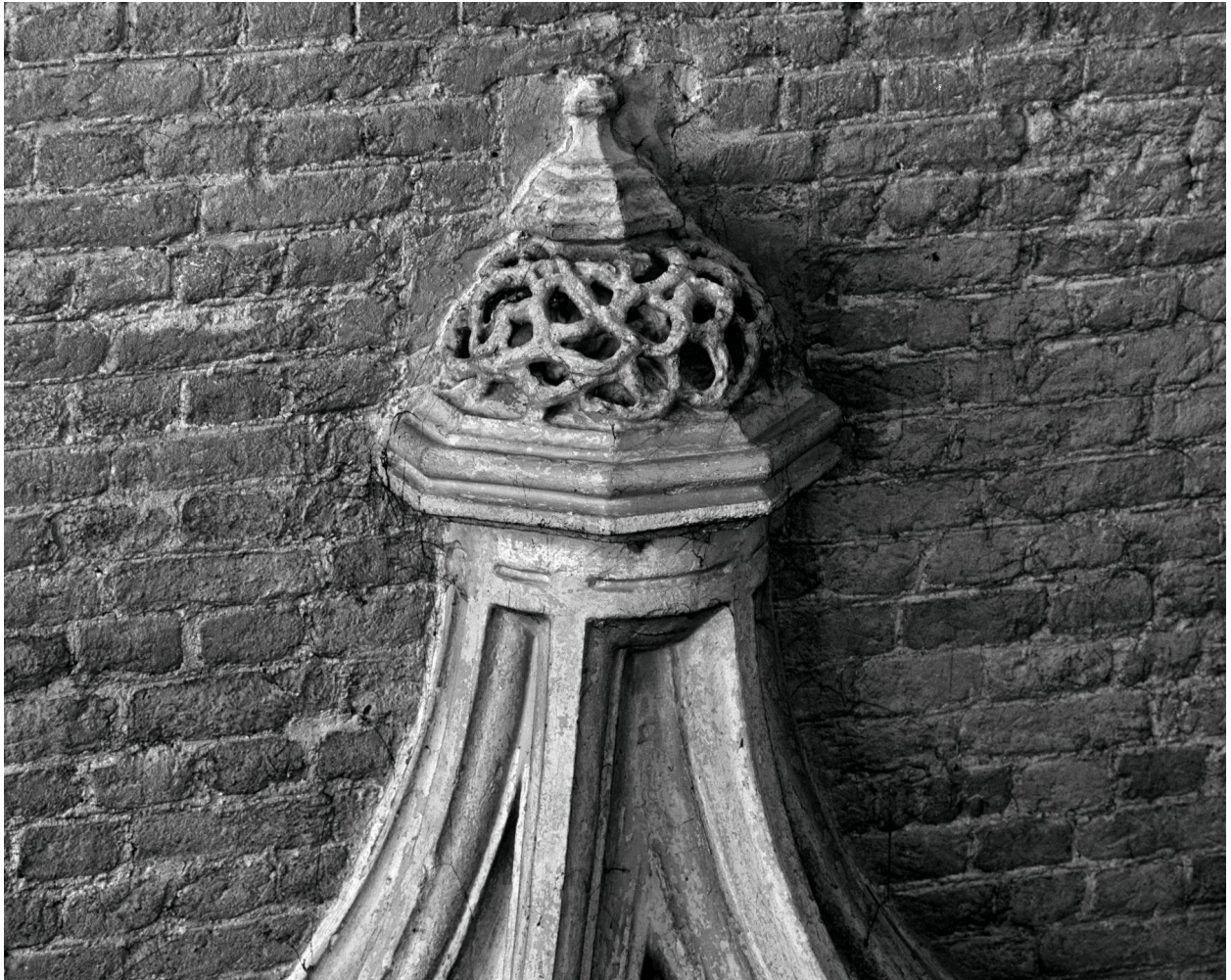
Grande sacristie, voûtement, détail : culot, mur ouest.
