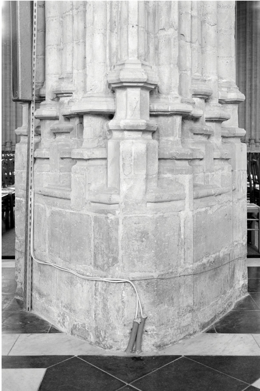
Nef, détail : 5e pilier sud, partie de la base du côté du collatéral.
