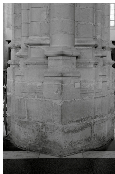
Nef, détail : 5e pilier sud, partie de la base du côté de la nef. Phot. Jean-Michel Périn IVR31_19885901503X
