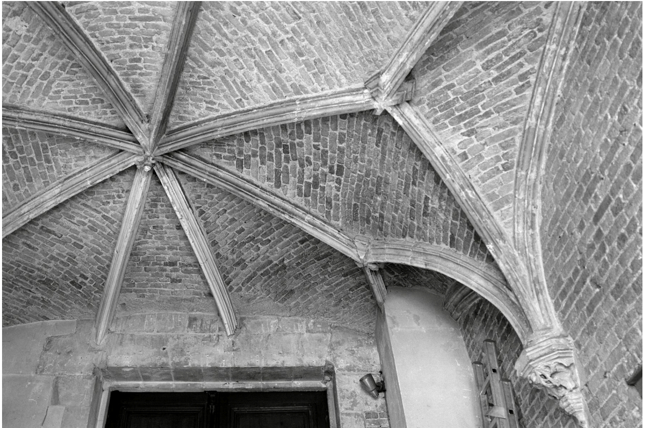
Petite sacristie : voûtement.
