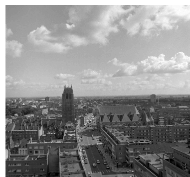
Depuis le beffroi de l'hôtel de ville, vue générale de l'église Saint-Eloi, séparée de sa tour par le tracé de la rue Clémenceau. Phot. Jean-Michel Périn IVR31_19885901697X
