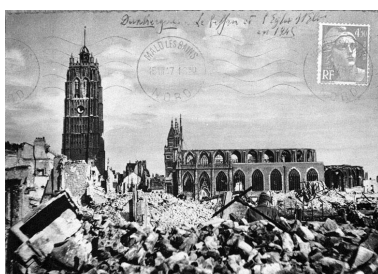
L'église et la tour vues du sud, entre 1940 et 1945. Repro. Jean-Michel Périn IVR31_19875903538XB
