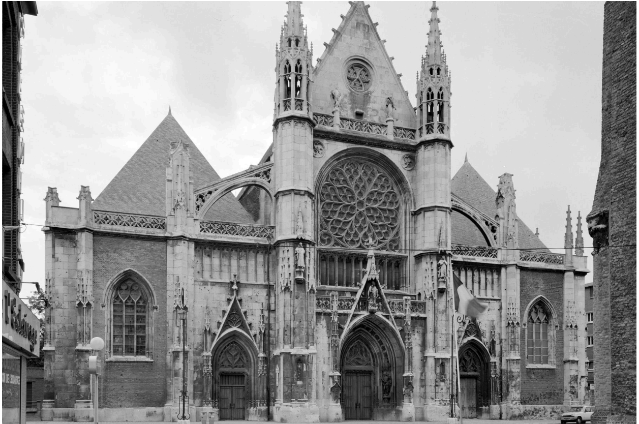
Vue générale de la façade ouest.
