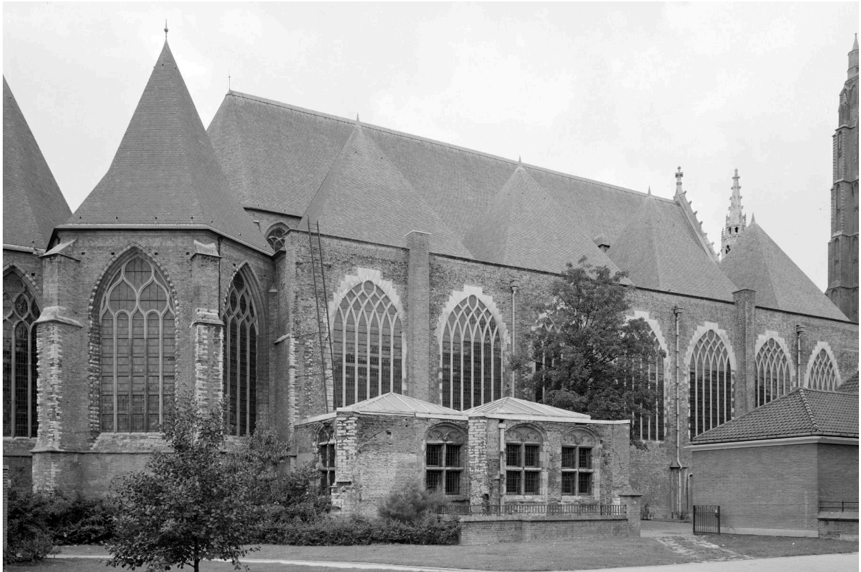
Vue de la façade nord.
