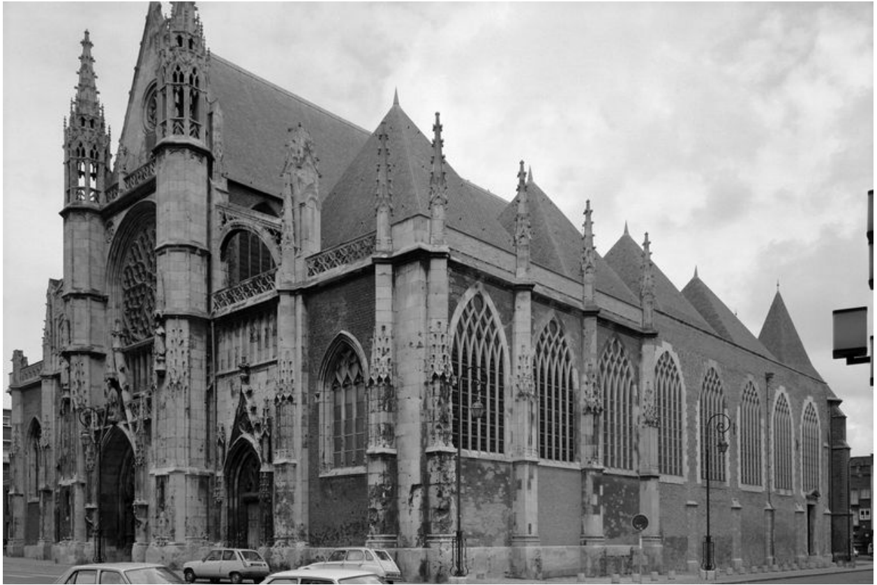
Vue générale d'angle sud-ouest.
