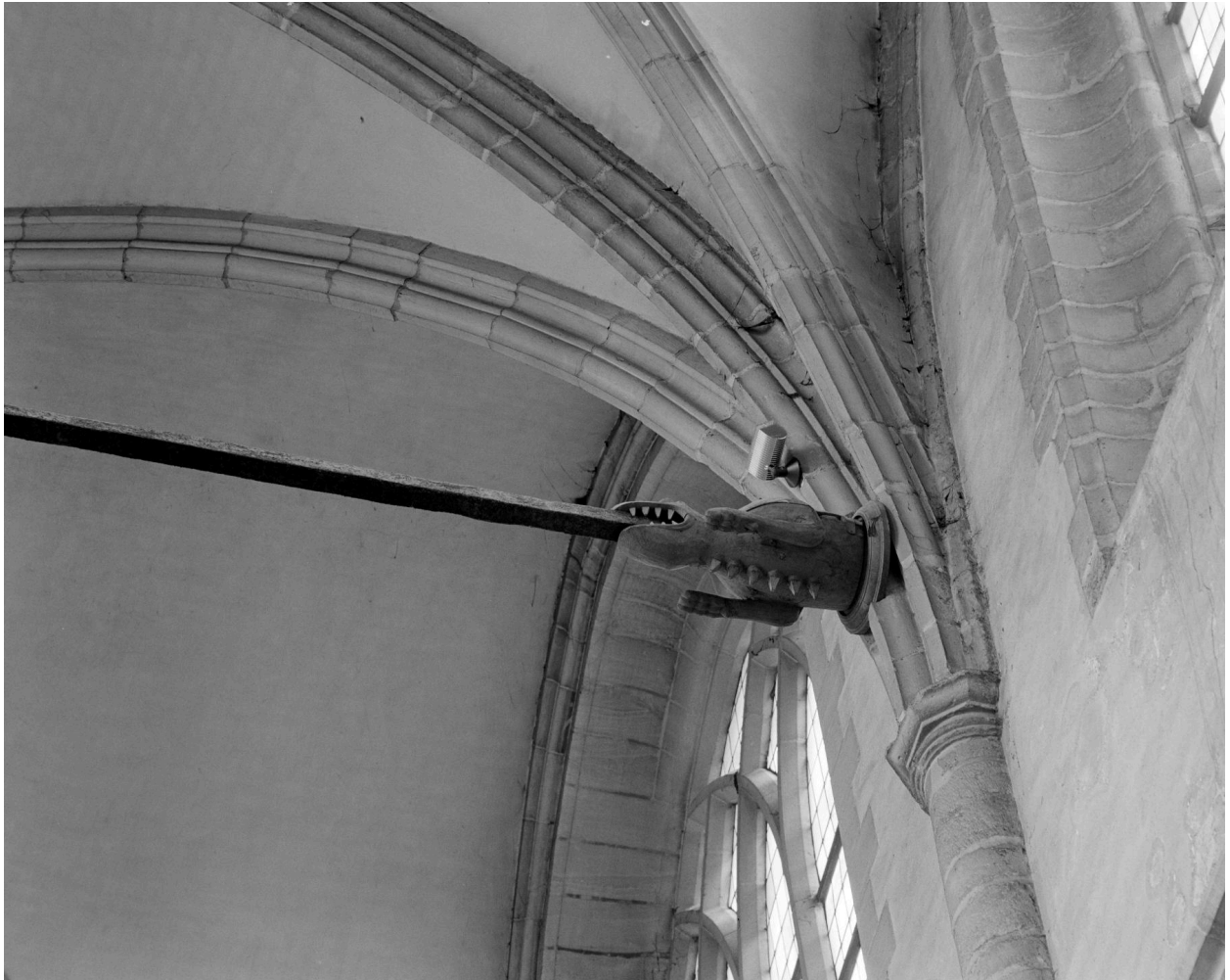
Nef, détail : 6e travée, engoulant sud et départ de voûtes.
