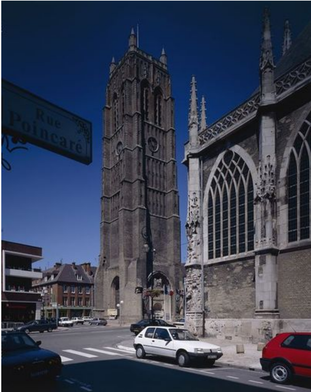
Vue d'ensemble des premières travées et de la tour.
