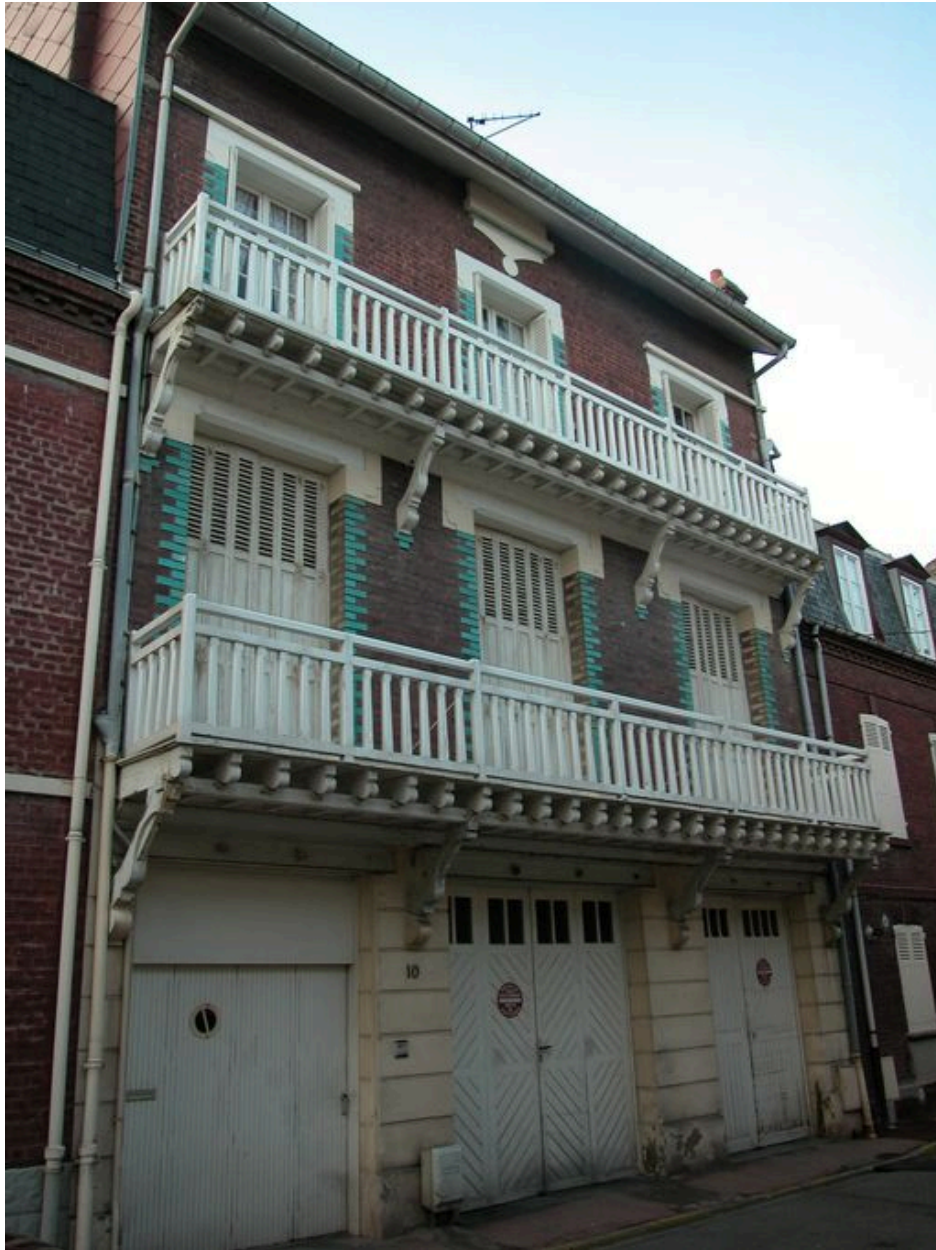
Immeuble avec garages au rez-de-chaussée, impasse Jules-Verne.
