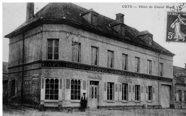
Etat avant 1914 (AP). Phot. Jean-Michel Périn IVR22_19856000398XB
