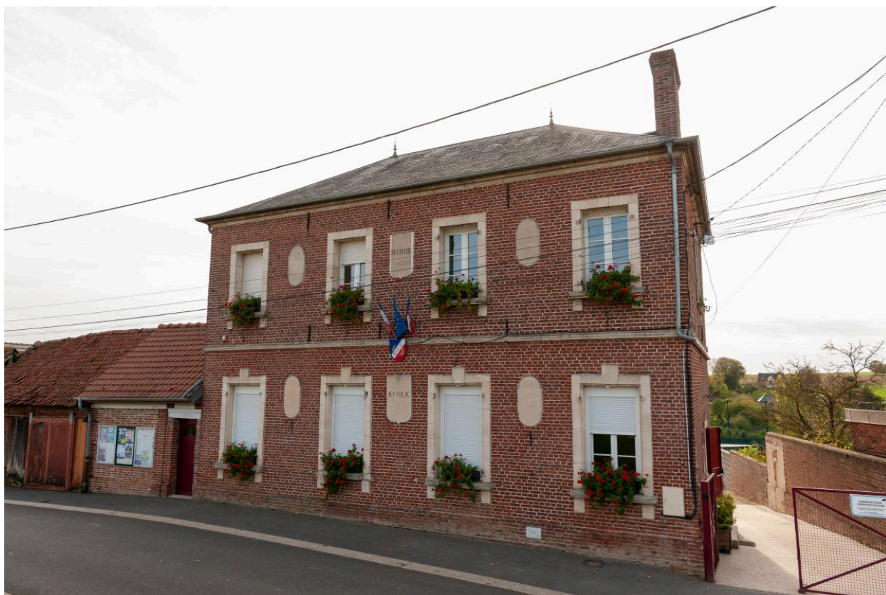
Mairie-école, vue depuis le nord-est.
