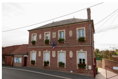
Mairie-école, vue depuis le nord-est.
