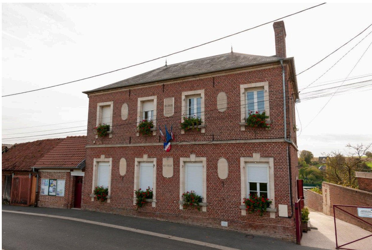
Mairie-école, vue depuis le nord-est.
