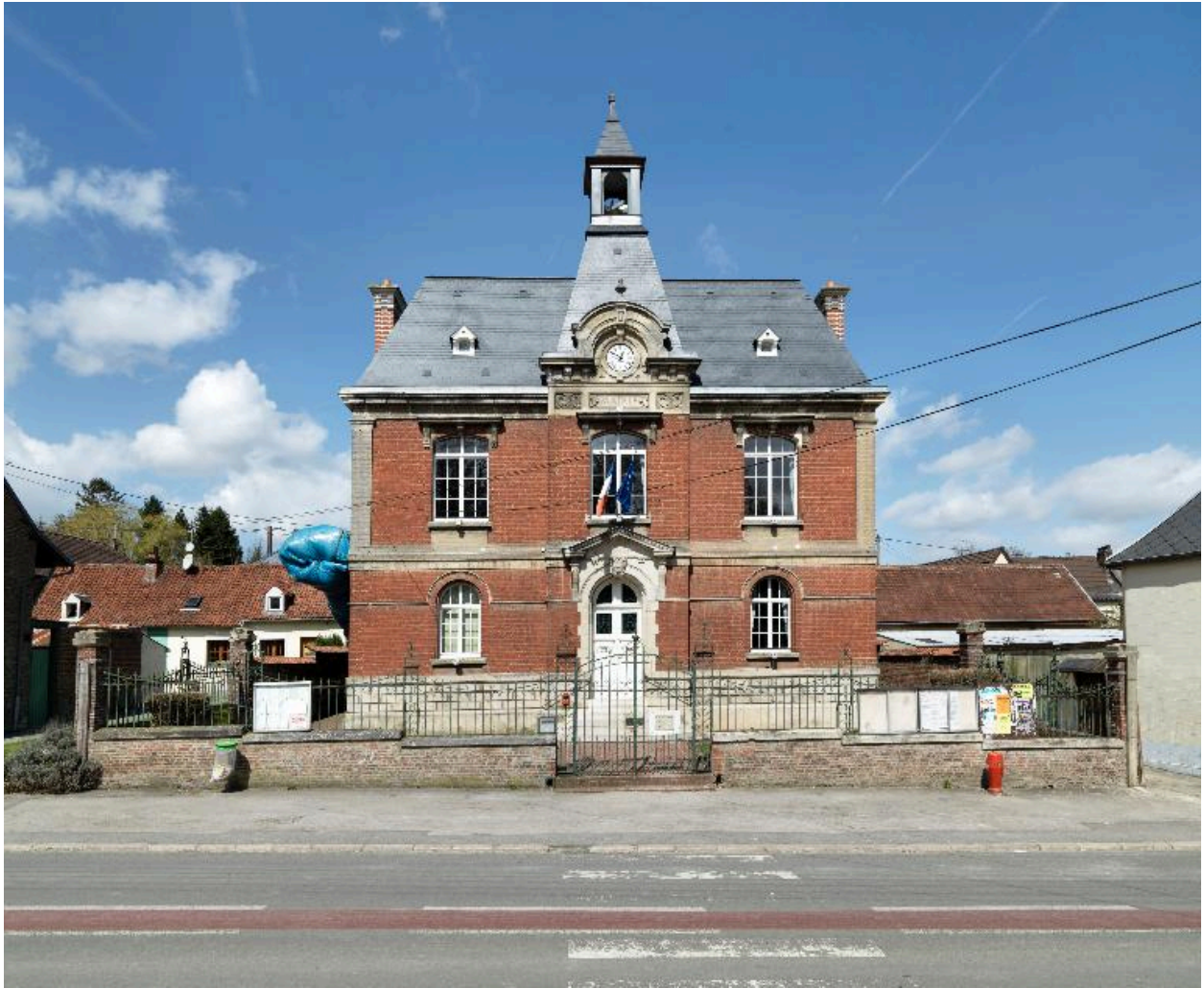
Vue d'ensemble de la façade sur rue.
