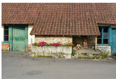
Ancien puits et ancienne pompe à eau, 16 rue de Vieulaines. Phot. Thierry Lefébure IVR32_20238000589NUCA
