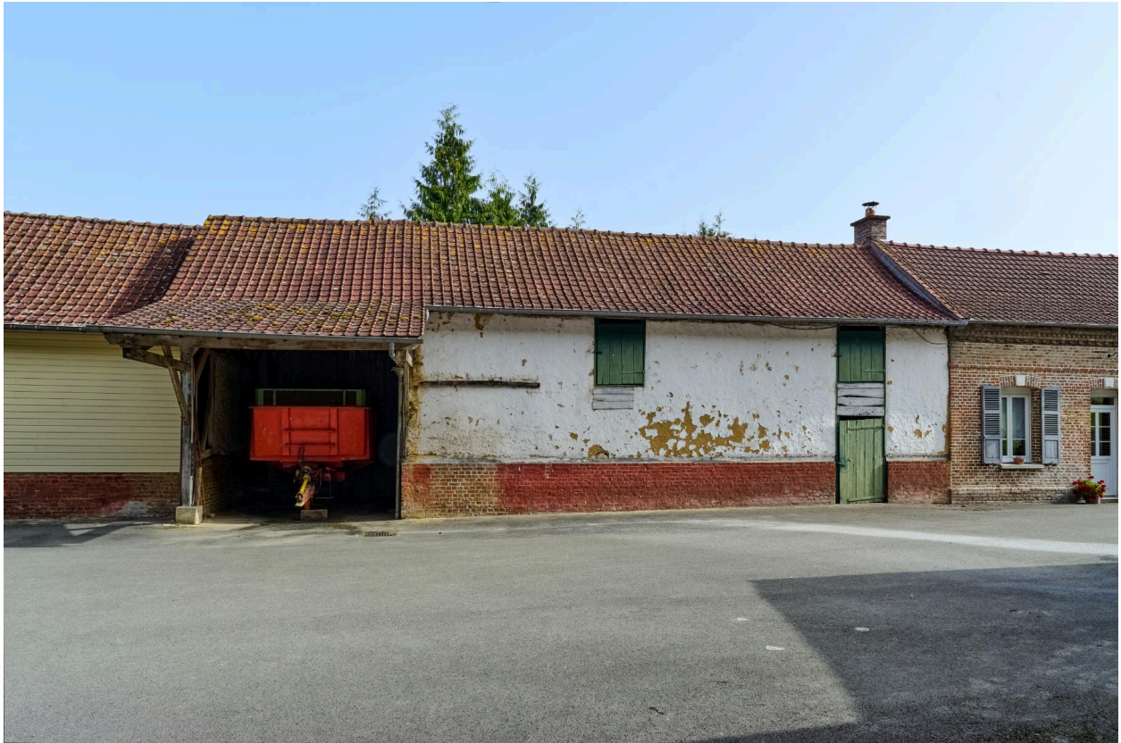
Édifice agricole en brique et pans de bois, 16 rue de Vieulaines.
