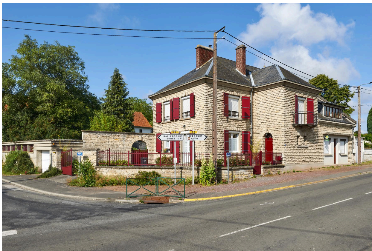
Ferme 1 et 3 rue de Haut, vue prise depuis le nord-est.
