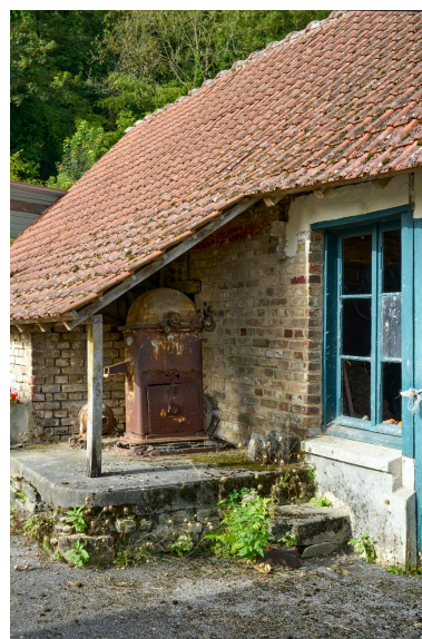
Ancienne pompe à eau, 16 rue de Vieulaines. Phot. Thierry Lefébure IVR32_20238000591NUCA
