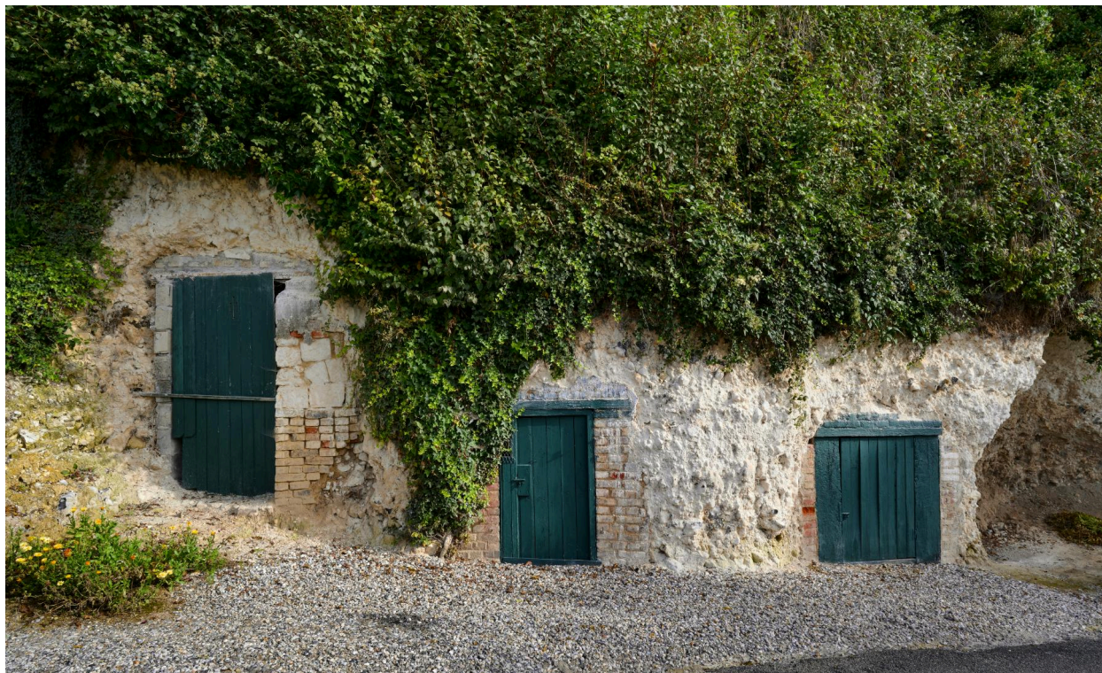
Entrées des anciennes carrières, rue de la Motte.
