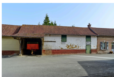
Édifice agricole en brique et pans de bois, 16 rue de Vieulaines. Phot. Thierry Lefébure IVR32_20238000592NUCA
