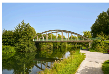
Pont entre Fontaine-sur-Somme et Cocquerel, vue prise depuis l'ouest. Phot. Thierry Lefébure IVR32_20238000633NUCA
