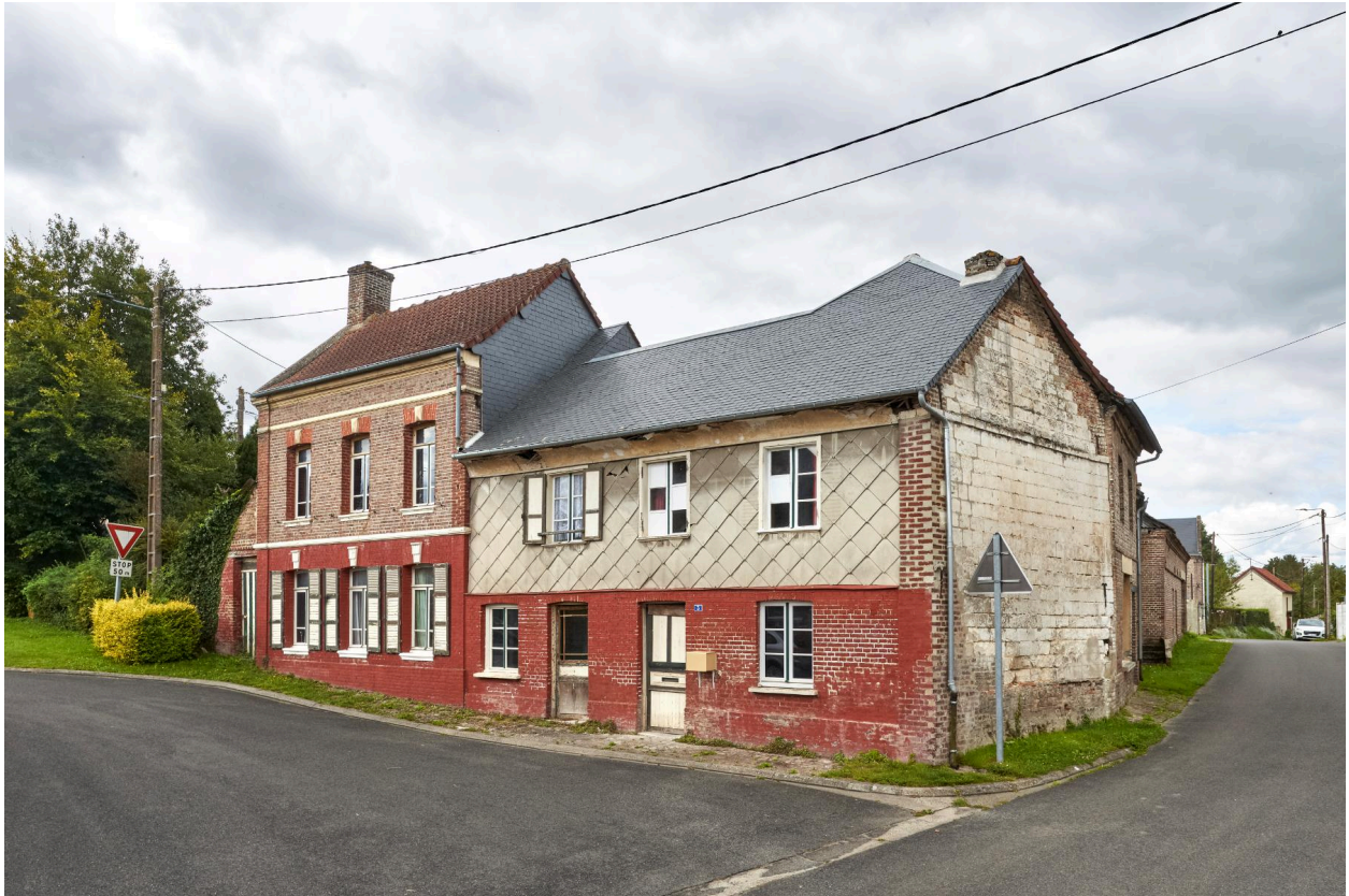
Maison, magasin de commerce Crimet-Rose, puis Rabouille-Pécourt, boulangerie, hôtel de voyageurs, puis salle de spectacle, 3 place Jeanne de Fontaine, vue prise depuis le nord-est.
