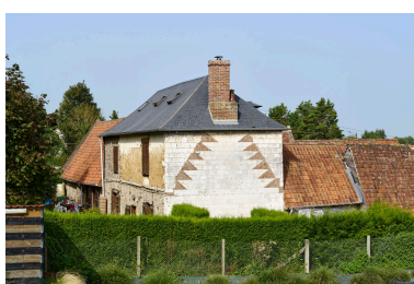
Pignon à couteau picard surélevé, 17 rue de haut. Phot. Thierry Lefébure IVR32_20238000545NUCA
