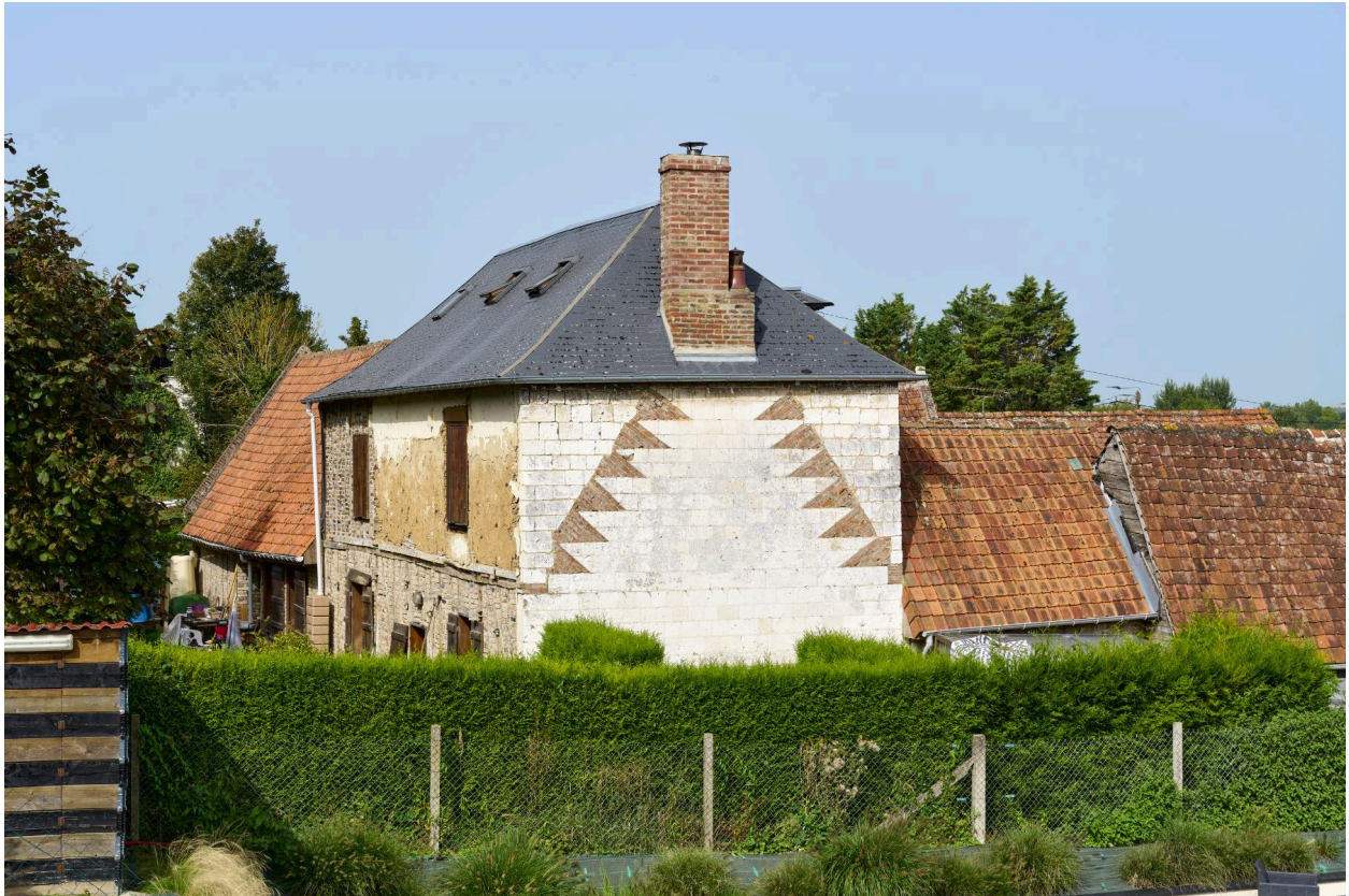
Pignon à couteau picard surélevé, 17 rue de haut.
