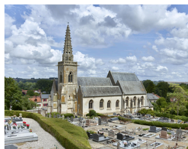
Église Saint-Riquier de Fontaine-sur-Somme, vue prise depuis le cimetière. Phot. Thierry Lefébure IVR32_20238000329NUCA
