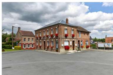
Mairie de Fontaine-sur-Somme, vue prise depuis le sud-est. Phot. Thierry Lefébure IVR32_20238000555NUCA
