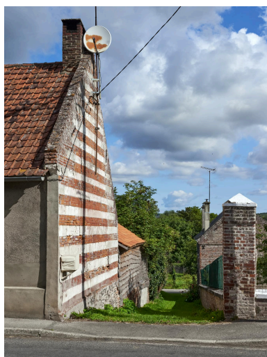
Ruelle coupe-feu, entre la rue de Haut et la rue Saint-Martin. Phot. Thierry Lefébure IVR32_20238000577NUCA
