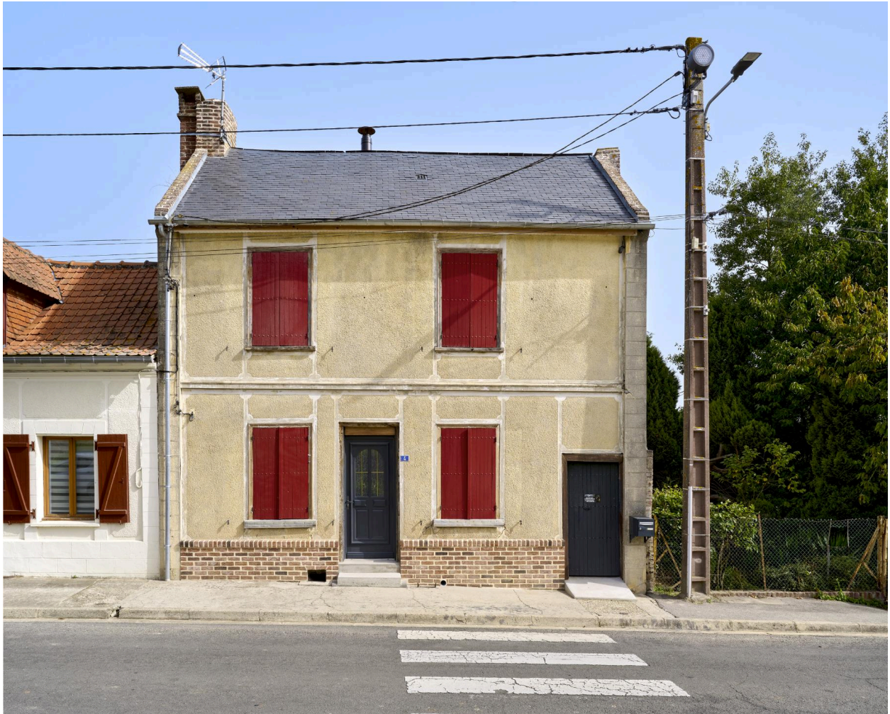
Maison en pans de bois, face à l'église, 4 rue de Haut.
